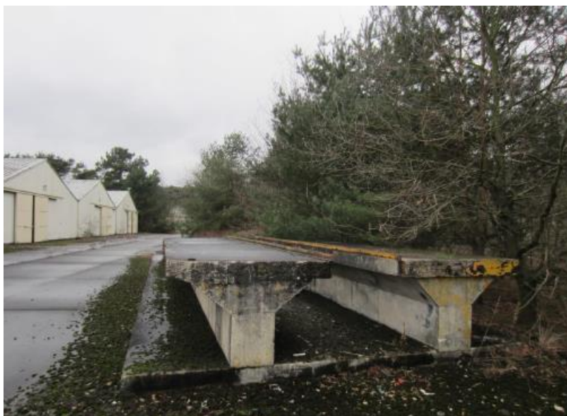
Figuur 8: Zone 3 en 9 (© BOVA ENVIRO+ NV) 14
