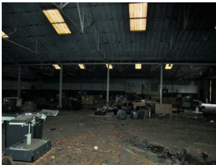
Figuur 7: Zone 3 en 8 (© BOVA ENVIRO+ NV) 13
