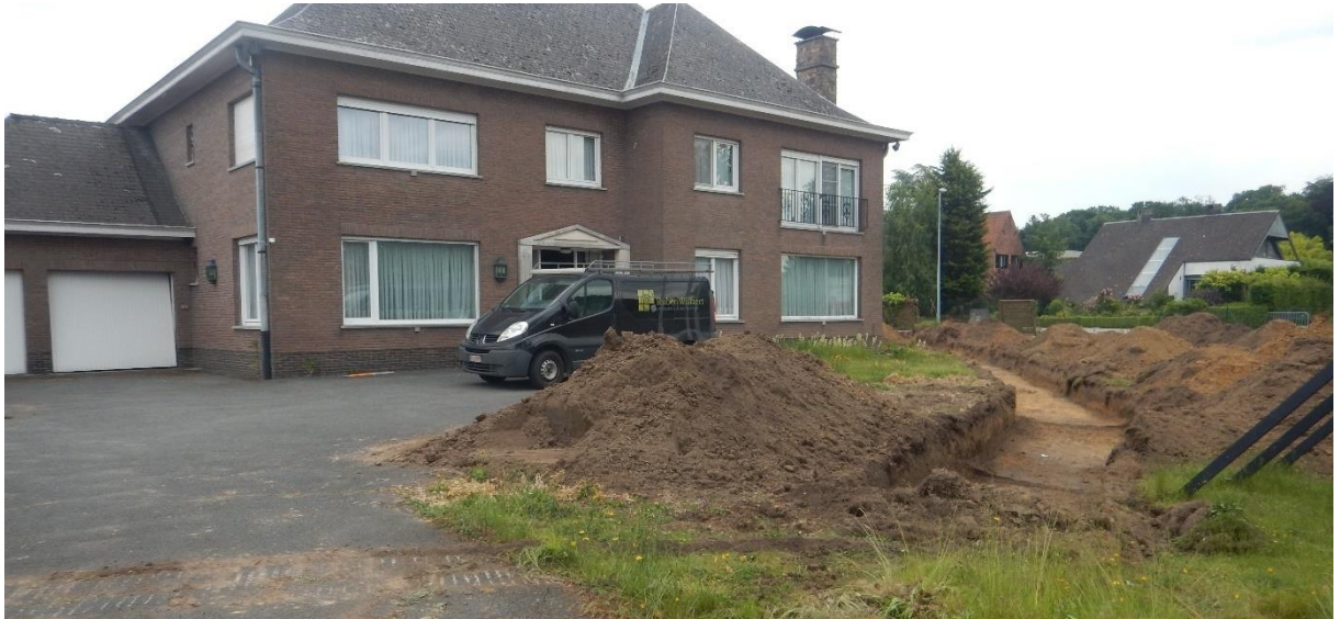
Figuur 12: Toestand terrein voor sloop (fase 1)
