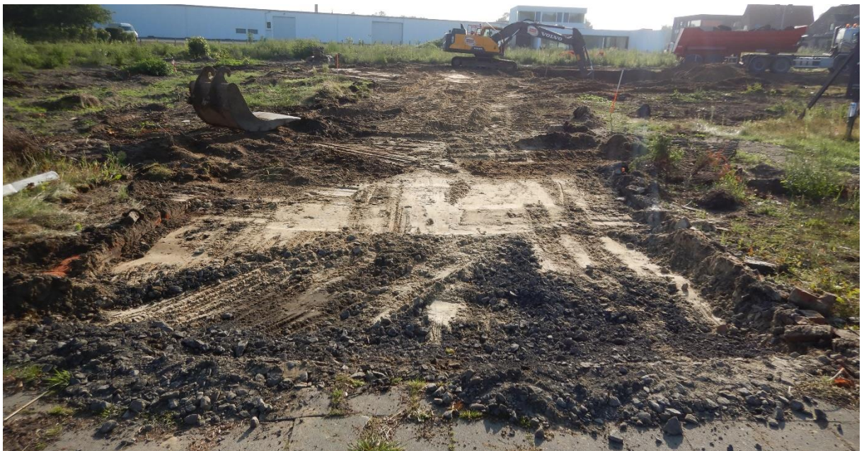
Figuur 13: Toestand terrein na sloop (fase 2)
