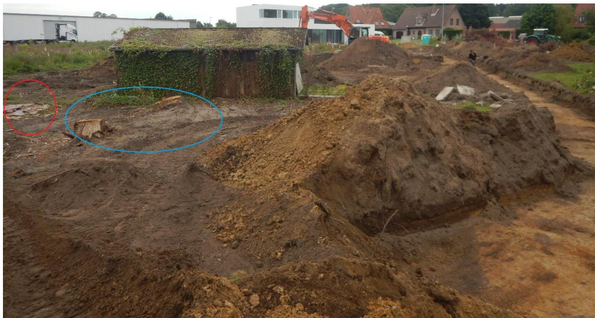
Figuur 6: Garagebox, Rode cirkel = asbest, Blauwe cirkel = boomwortels
