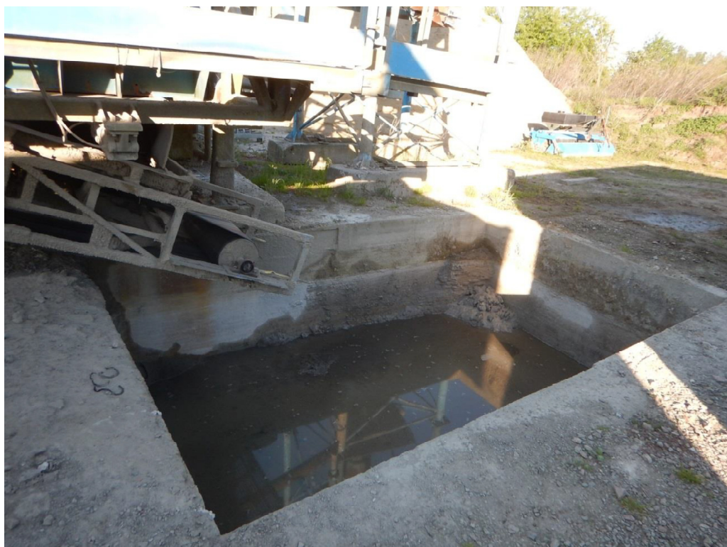
Afb. 3. Voorbeeld van een diepere uitgraving in de werfzone (Foto: All-Archeo).
