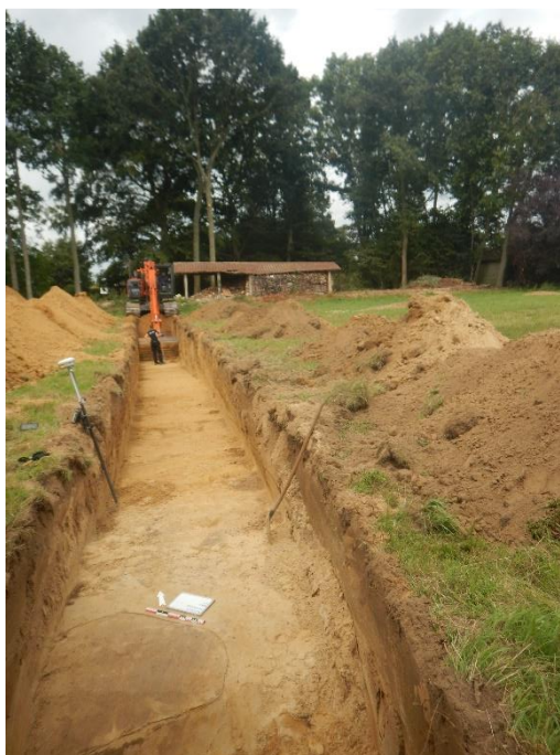
Figuur 7: Aanleg van de sleuven langs de houten constructie heen.
