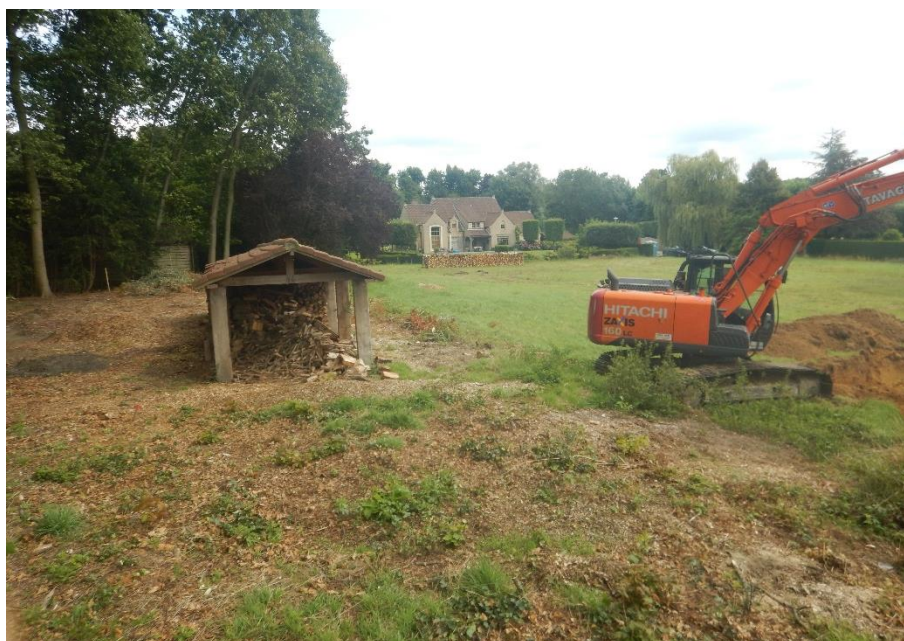
Figuur 2: Zicht op het terrein met de aanwezige houten constructie, foto vanuit het westen.
