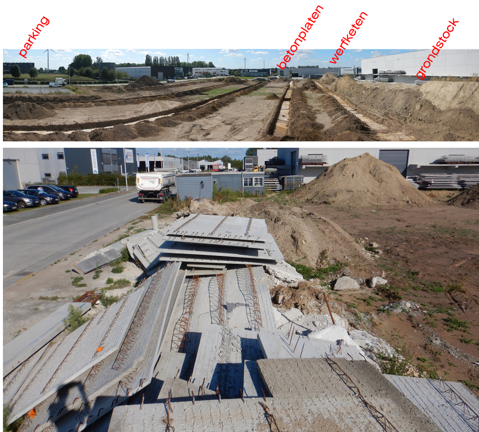
Figuur 3. Zicht op een deel van de uitgevoerde proefsleuven met aanduiding van enkele obstakels. Onder: stapel van betonplaten en de werfketen in het westelijke deel van het onderzoeksgebied.
