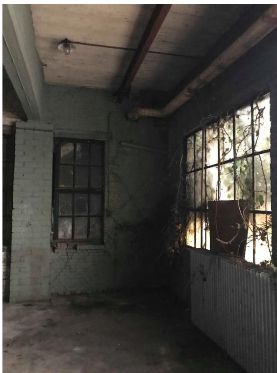
Figuur 18: Binnenkant loods: detail 1 (© J. Verrijckt Archeologie & advies bvba)
