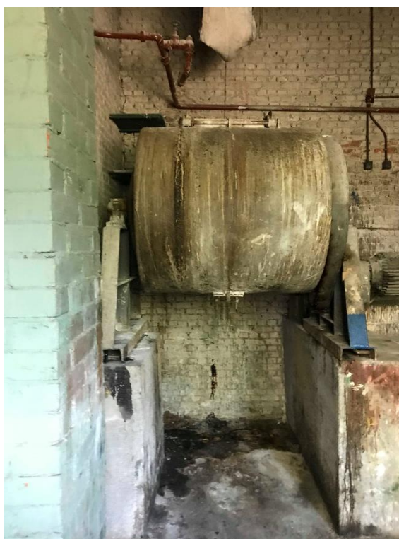
Figuur 19: Binnenkant loods: detail 2 (© J. Verrijckt Archeologie & advies bvba)
