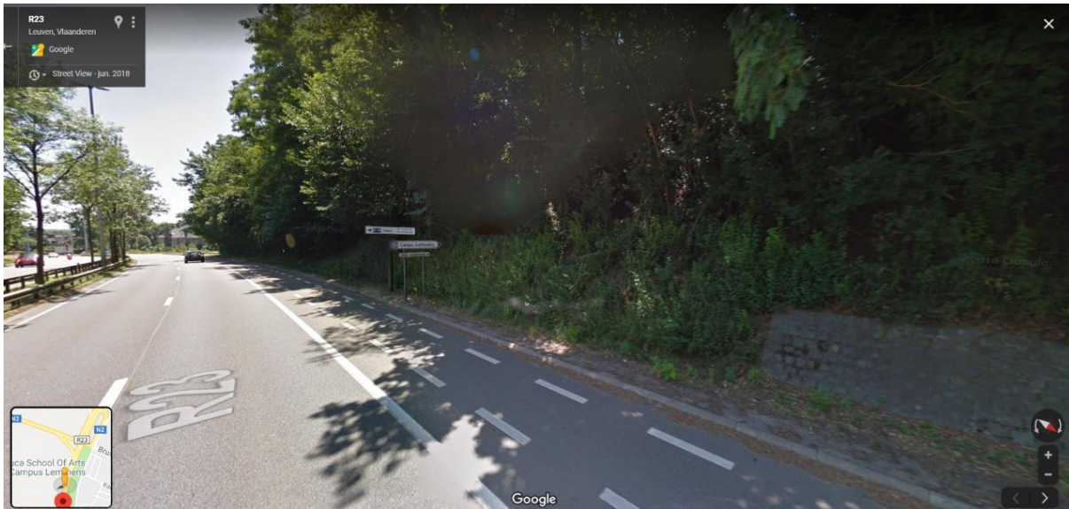
Figuur 3: Streetviewbeeld 9 van huidige situatie: overgang metselwerk talud
