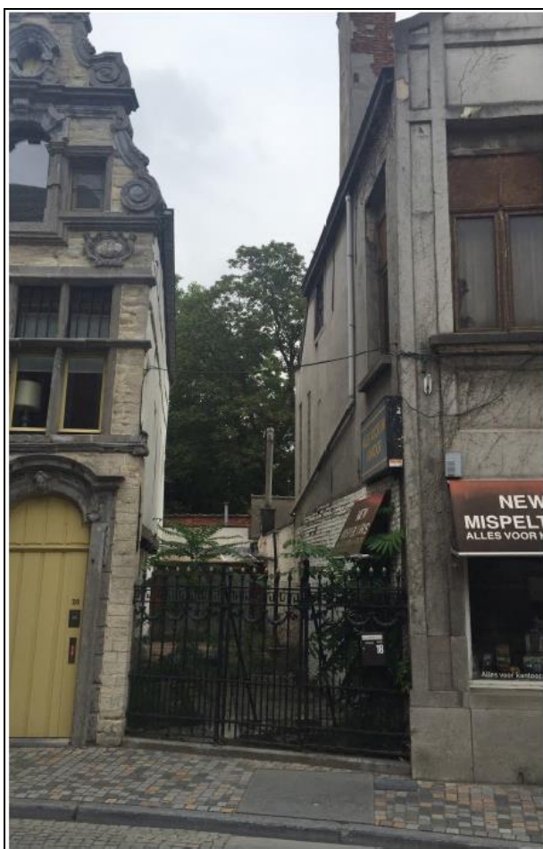
Figuur 7: Huidige situatie - Langsgevel diephuis (Bron: Initiatiefnemer 2019).
