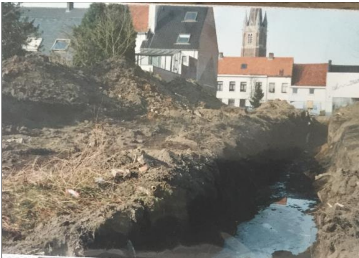
Figuur 18: Zicht op de sleuf vanuit het zuiden (bron: opdrachtgever).
