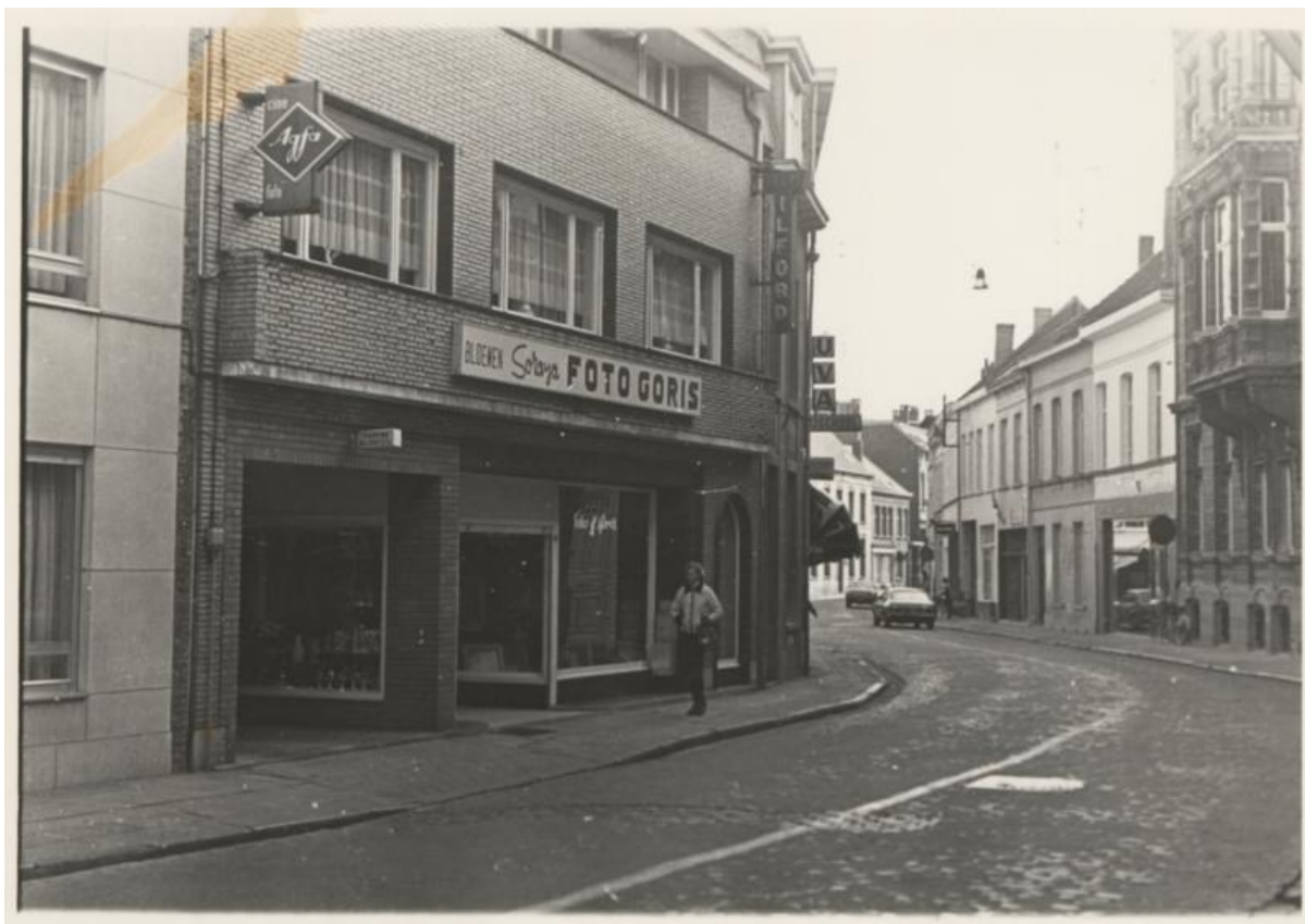
Fig. 18 FOTO 4. Zicht op het huidige huisnummer 63. De foto dateert van na 1969, toen een inrit werd gecreëerd naar de achterliggende parkeerplaatsen. Voorheen stond er zowel links als rechts een boogdeur in de gevel, zoals blijkt uit bouwdoossier 276/52 van 1952. © http://www.erfgoedbanknoorderkempen.be/erfgoed/4798-herentalsstraat : fotostudio Goris. Inventarisnummer: Foto 05959-03
