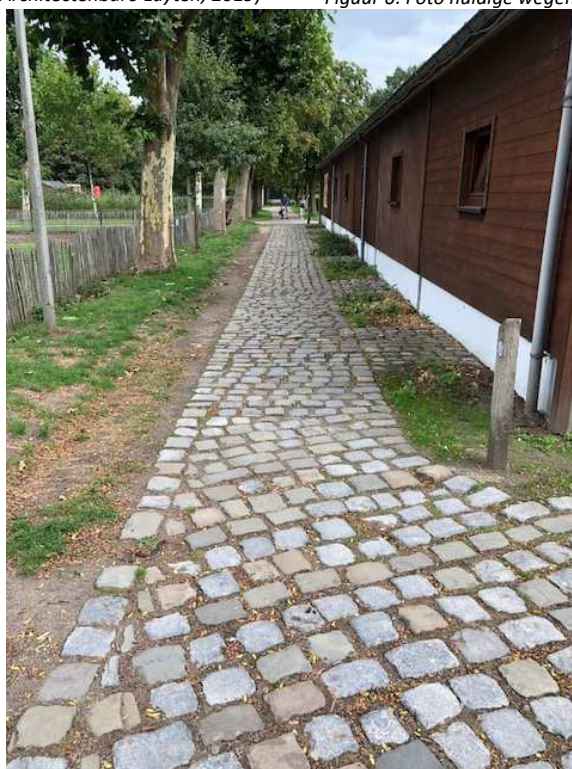
Figuur 7: Foto huidige wegenis (Architectenburo Luyten, 2019)
