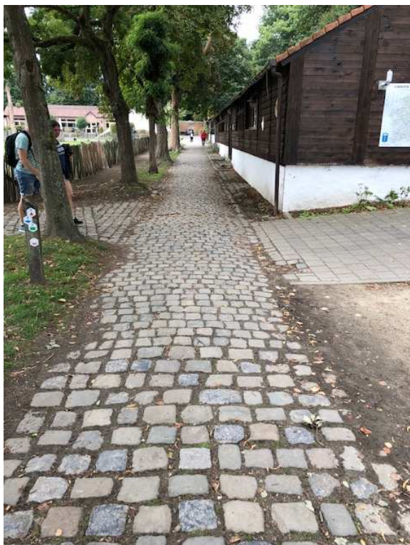
Figuur 5: Foto huidige wegenis (Architectenburo Luyten, 2019)
