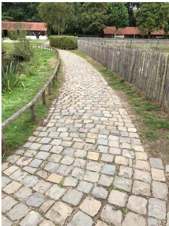
Figuur 6: Foto huidige wegenis (Architectenburo Luyten, 2019)
