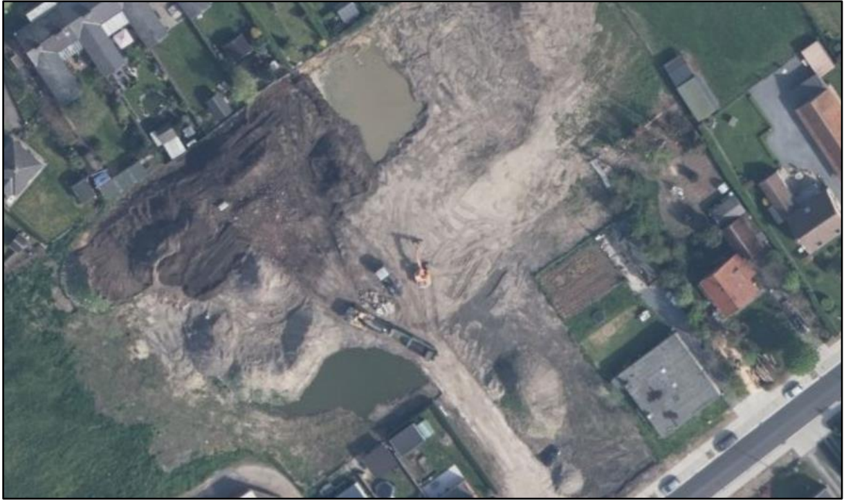
Figuur 30 Detail van de grondwerken op het terrein in 2016 (bron: geopunt.be).
