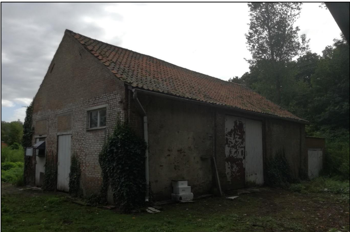
Figuur 7 Zicht op het bakstenen gebouw in het zuidwestelijke deel.
