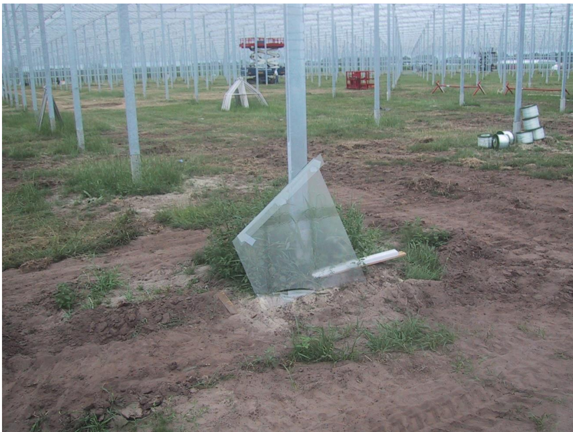
Fig. 7a en b : Foto's opbouw serre – uitboren funderingskuilen en opbouw sokkels paalfundering (© DLV/Gestelberries bvba).
