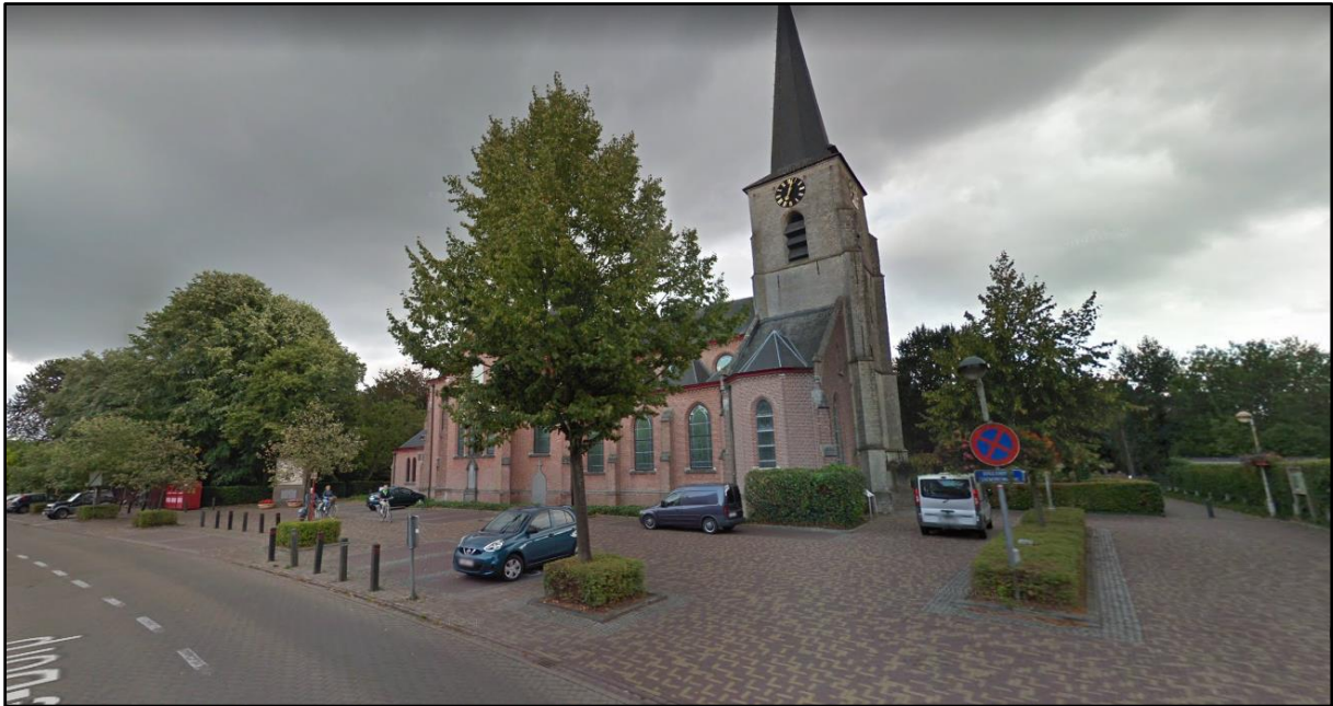
Figuur 4 Beeld vanuit het noordwesten op de kerk en de omringende verharding in de zuidelijke zone van het plangebied (bron: https://www.google.com/maps ).
