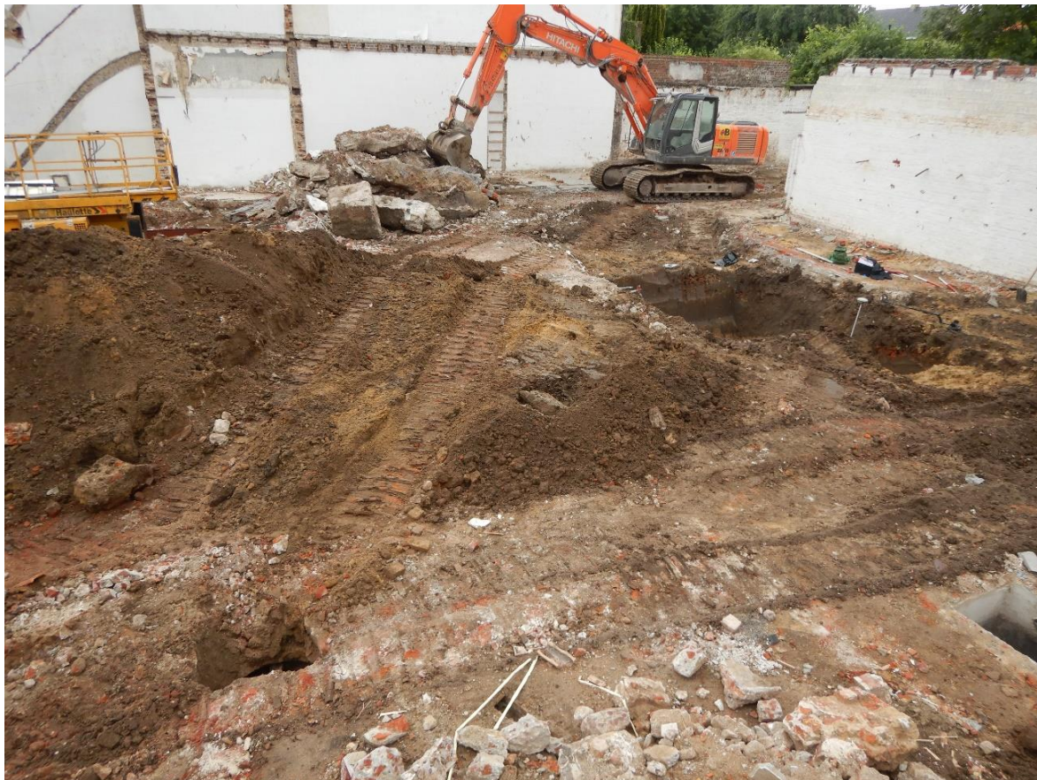
Figuur 10: Zicht op werkput 5 en recente waterputten linksonder en rechtsonder in beeld.
