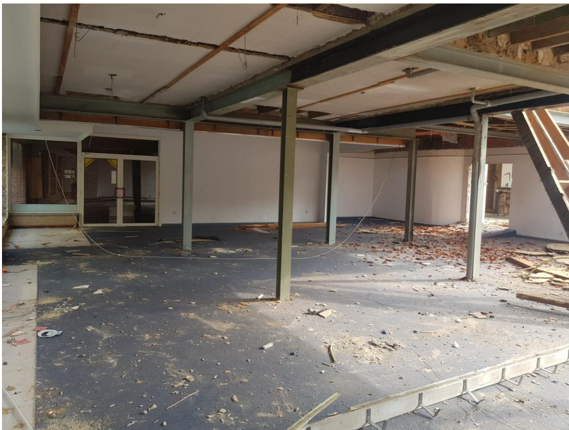
Figuur 39: Zicht op interieur en deel van de dragende elementen van de gesloopte bebouwing. 9
