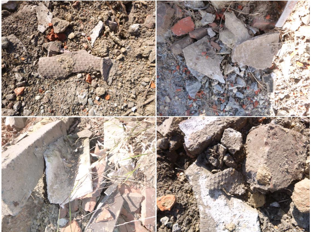
Afb. 10. Voorbeelden van asbest binnen het plangebied.
