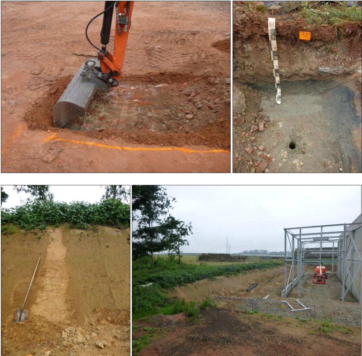
Figuur 9: Puinrijke en ondoordringbare oppervlakte enkele meters ten westen van de effectief uitgevoerde profielput 1 (links boven); het boorgat op de bodem van profielput 1 (rechts boven); het opgeschoonde bodemprofiel op de bouwputwand (links beneden); de locatie van het referentieprofiel in de hoek van de bouwput (rechts beneden).
