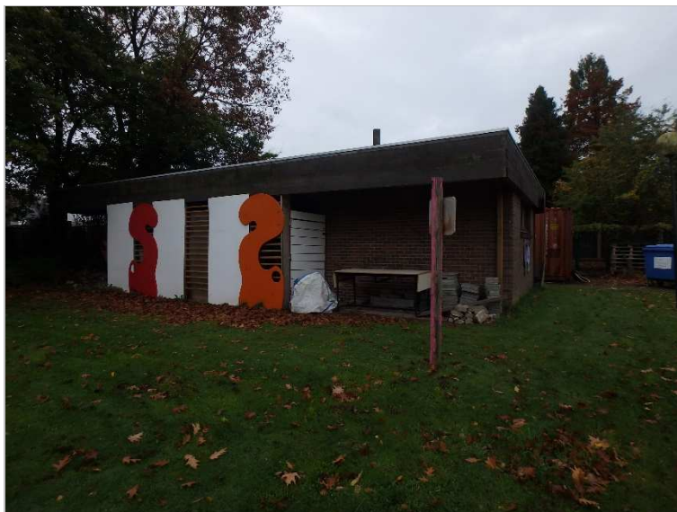
Figuur 43: Gebouwtje aan de Larestraat (Archebo bvba, 2017)
