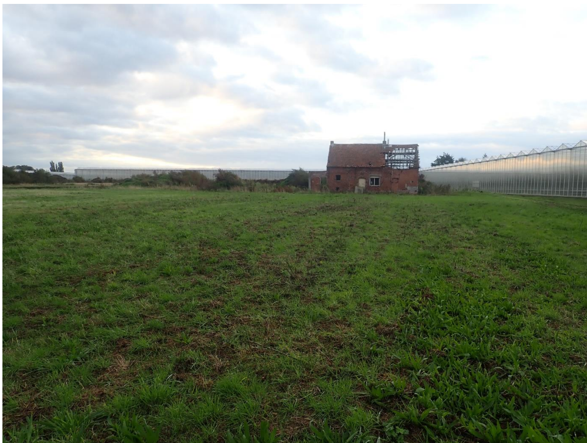
Figuur 6: zicht op enkele van de aanwezige structuren (© J. Verrijckt Bvba)
