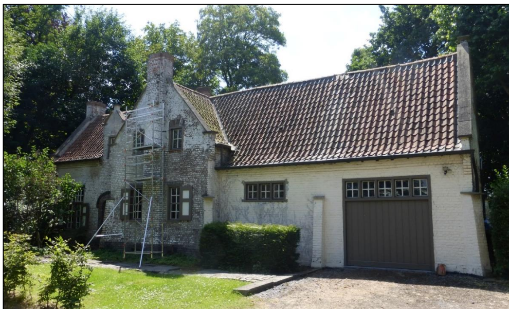
Figuur 26: Hoevenierswoning- ID 26465 (Inventaris Bouwkundig Erfgoed)
