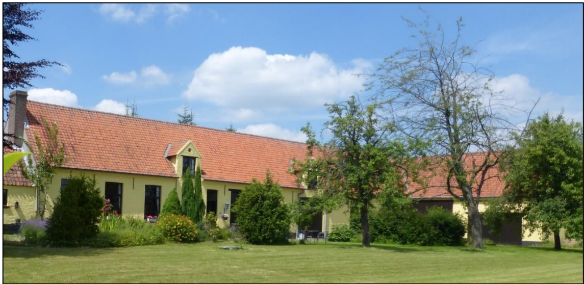
Figuur 25: Hoeve - ID 26467 (Inventaris Bouwkundig Erfgoed)
