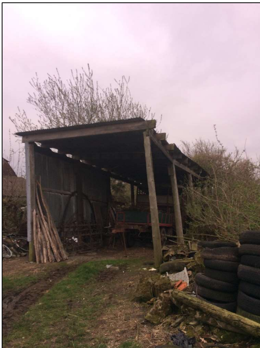
Figuur 11: hok/afdak aan de westzijde stalling (bron: eyckmans 2 Landmeterskantoor)
