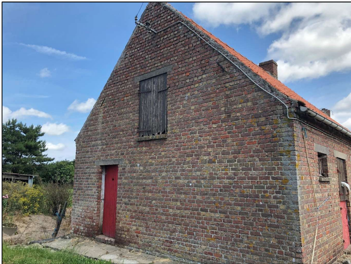
Figuur 8: linker zijgevel hoeve (bron: eyckmans 2 Landmeterskantoor)
