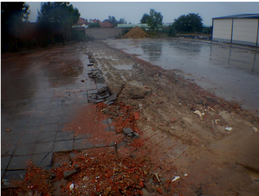
Figuur 3: Zicht het terrein met de opgebroken betegeling, foto vanuit het noorden.
