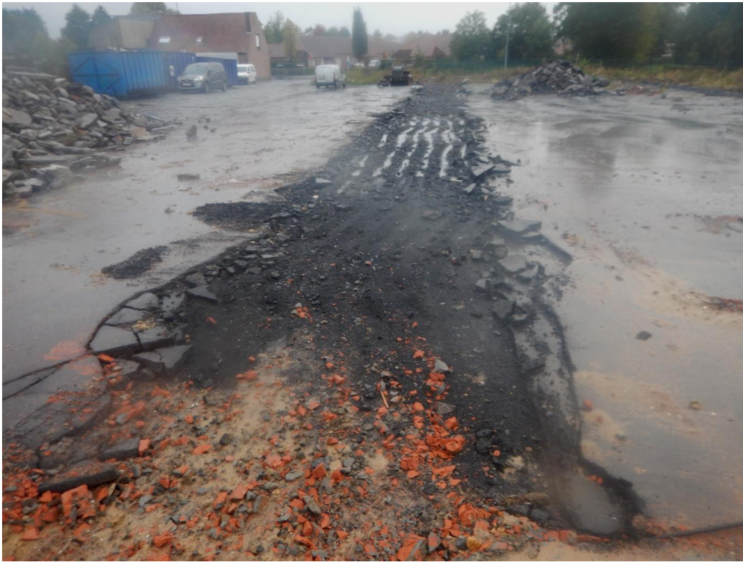
Figuur 2: Zicht op het terrein met de opgebroken asfaltlaag, foto vanuit het zuiden.
