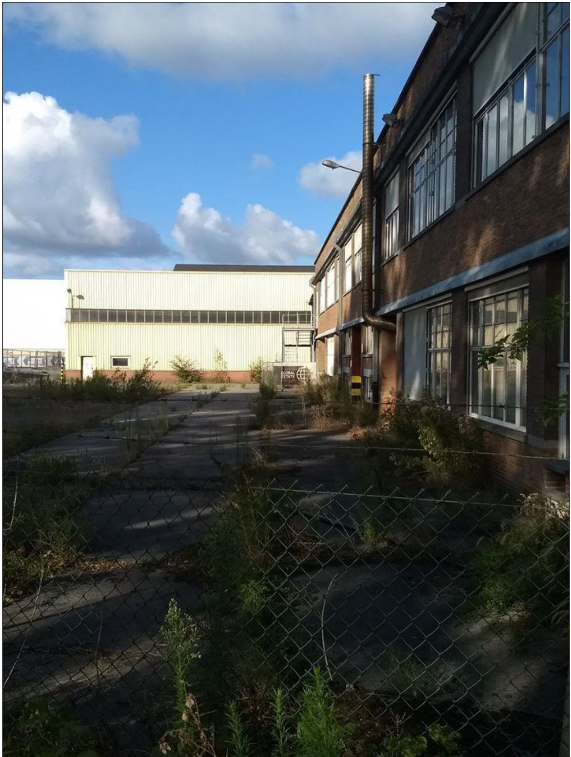
Figuur 6: Zuidzijde van het gebouw met omliggende verharding (bron: plaatsbezoek op 24/08/2018).
