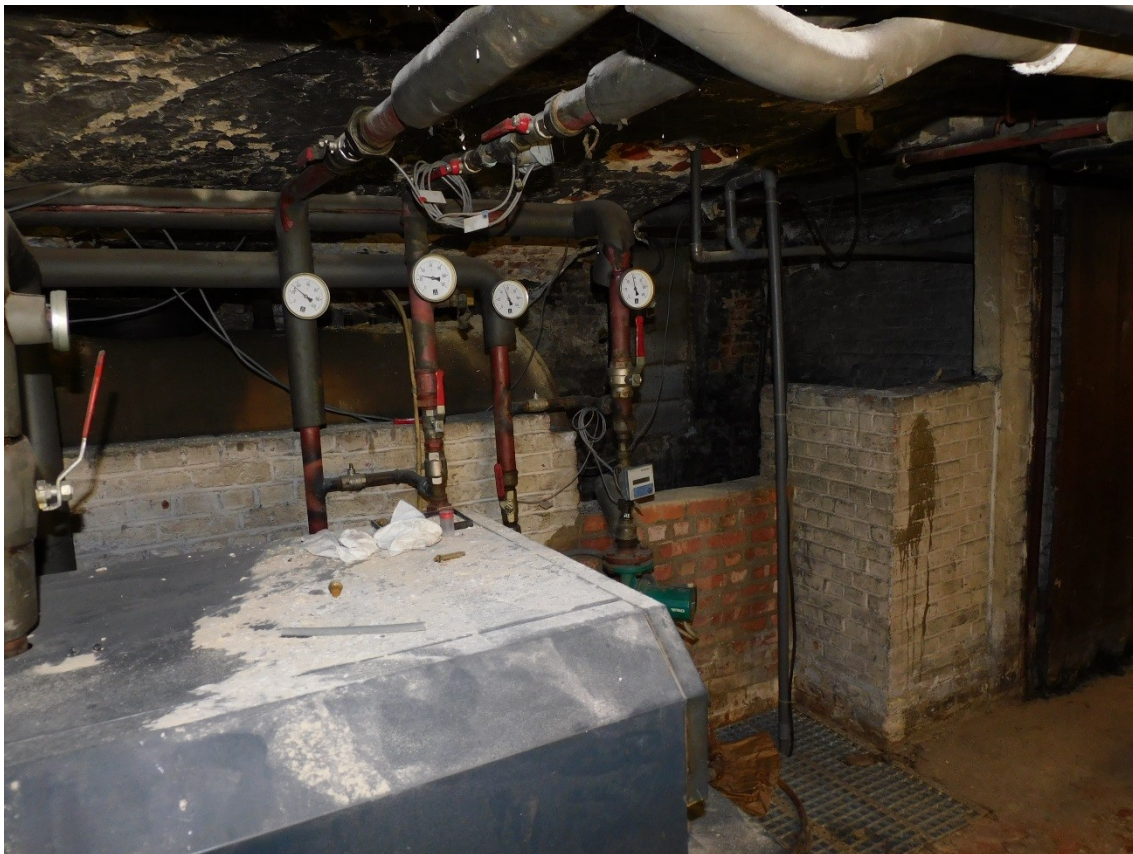
Figuur 10: Recente toevoegingen in de kelder
