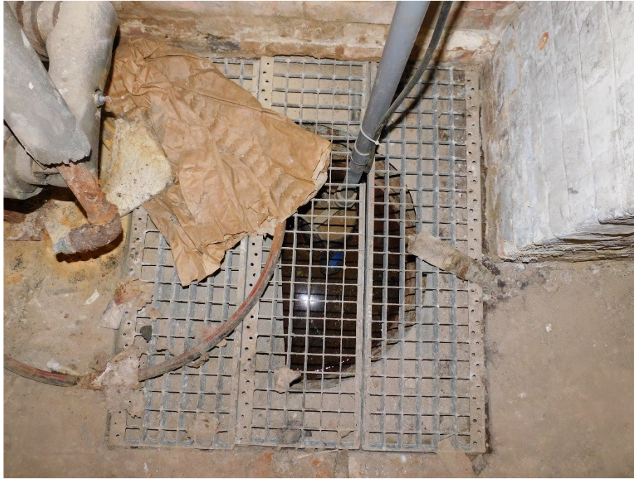
Figuur 9: Waterput in de kelder
