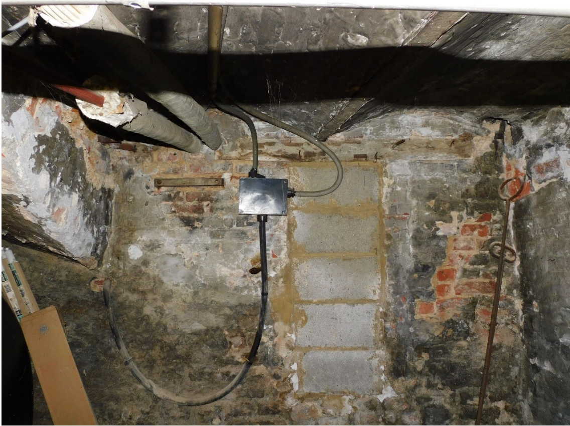
Figuur 7: Troggewelven en een dichtgemetst keldergat
