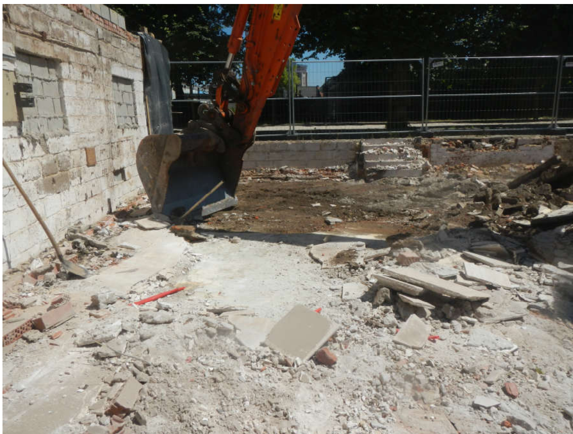
Afbeelding 1: Impressie van het ontmantelen van de oppervlakkige betonverharding.
