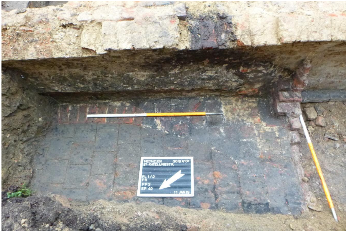
Figuur 62: Keldergewelf SP40A met zwarte aanslag in proefput 2 vlak 1-2 (Bron: ABO nv 2019)
