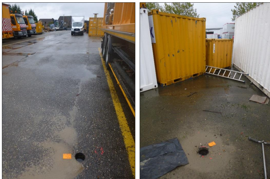
Figuur 6: Voorbeelden van de machinale boorgaten uitgevoerd door Besix nv ter hoogte van boring 8 (links) en 9 (rechts).
