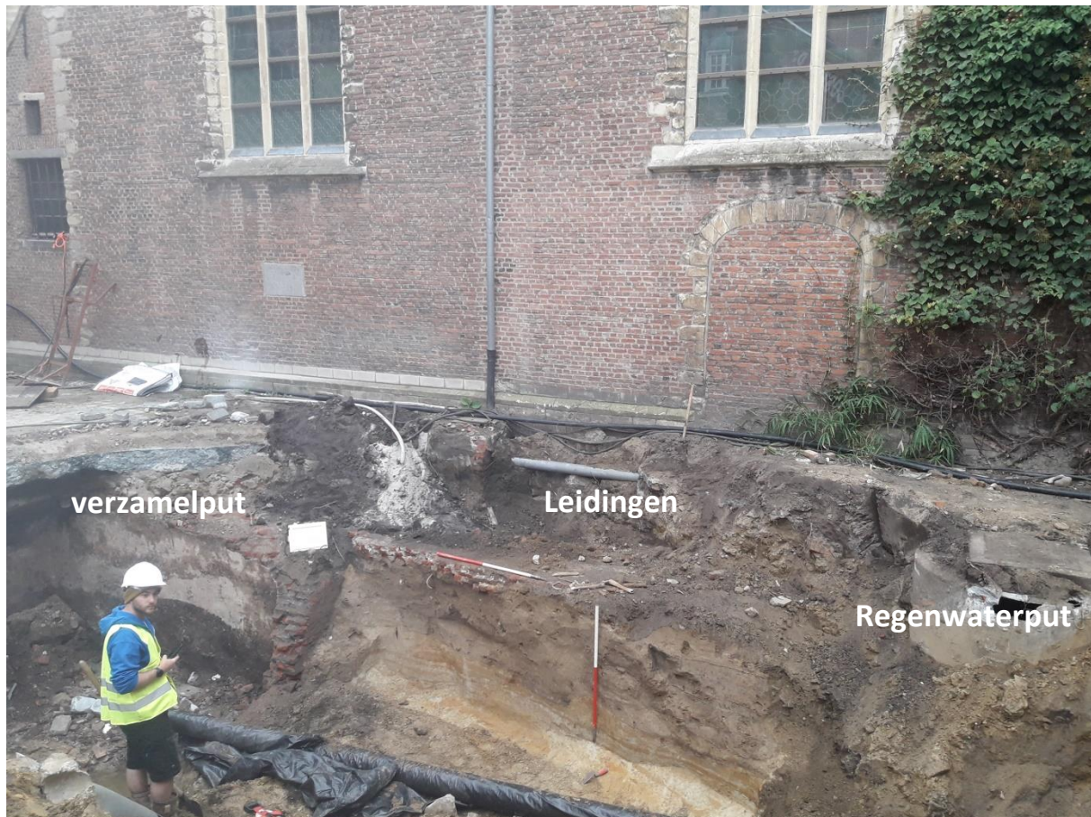
Figuur 22 Situatie in ter hoogte van de kelderzone, zicht richting de kapel. Links is het profiel verstoord door de 19 de -eeuwse kelder, rechts zit waterput, langsheen de gevel lopen afvoerbuizen.
