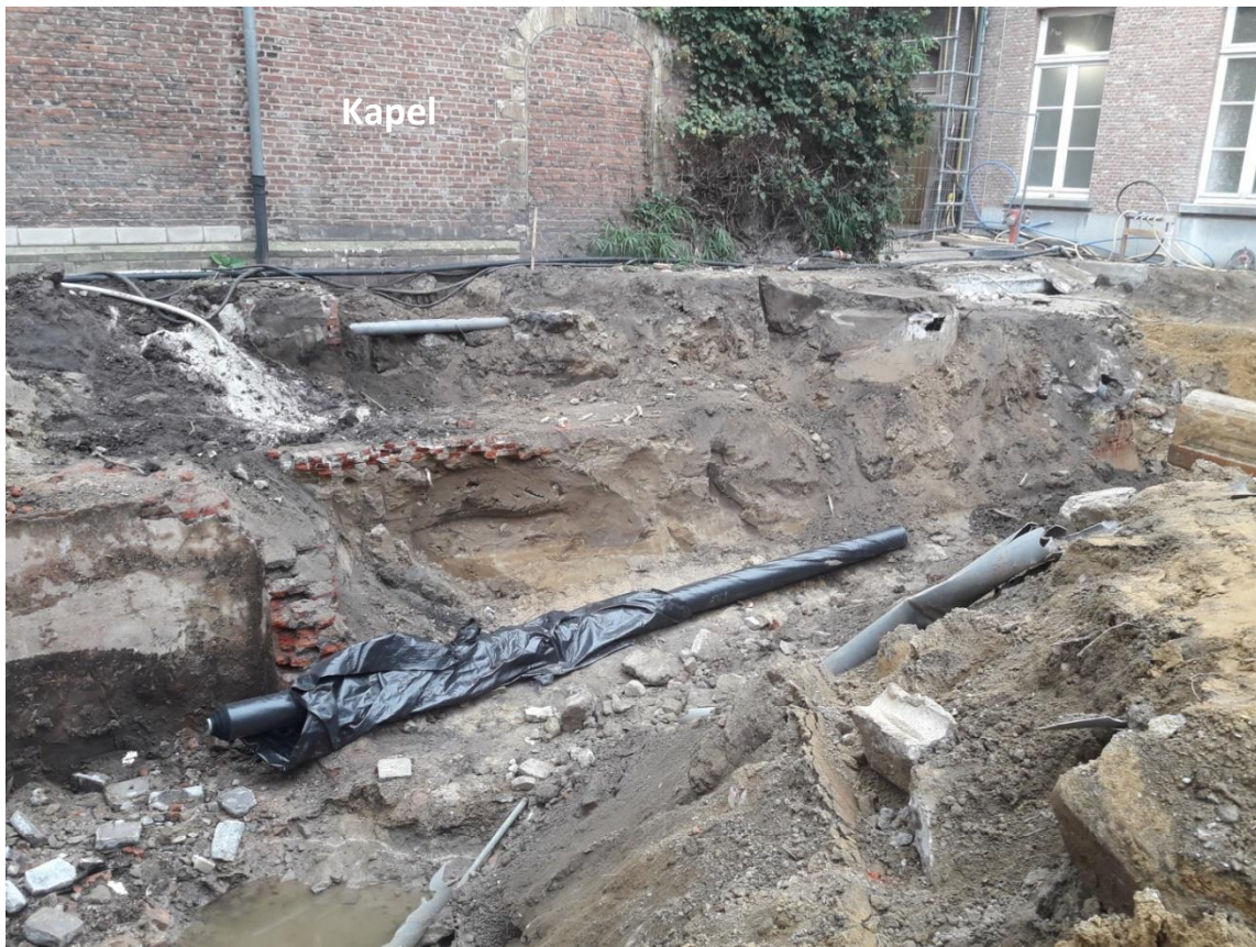
Figuur 5. Overzichtsfoto van de aangebrachte verstorening ter hoogte van proefput 1. Zicht op de zijde die werd geregistreerd.
