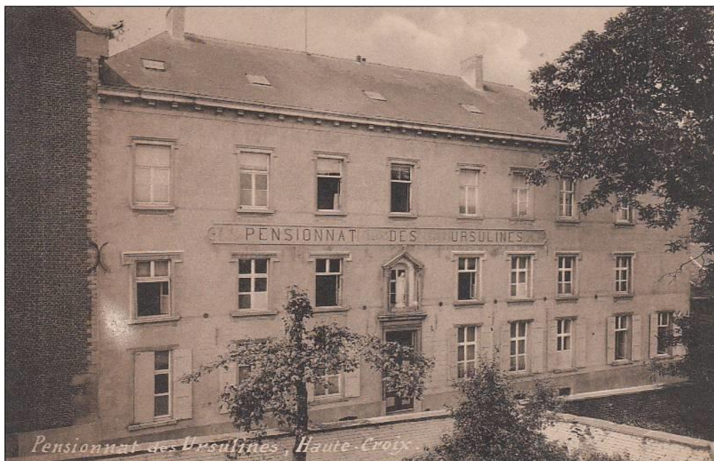
Figuur 14. De hoofdvleugel aan de Neerstraat.
