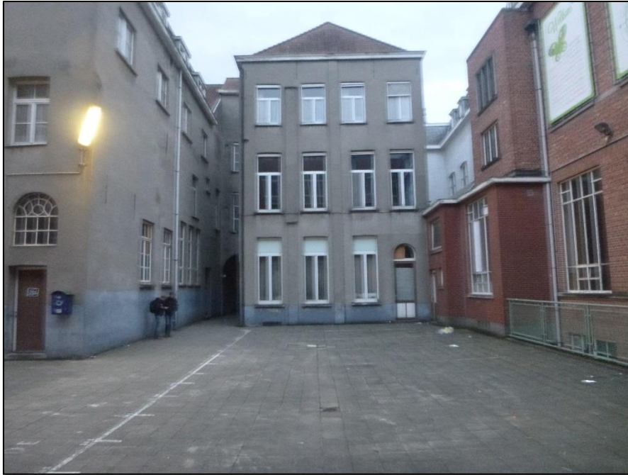
Figuur 5: Foto van de bebouwing aan Hoogstraat 6-8 met op de voorgrond de verhardingen. Genomen richting oostzijde (Hoogstraat). Links en centraal: huisnr. 8 / Rechts: huisnr. 6 (ABO nv 24/10/2019)
