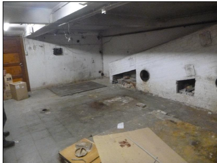
Figuur 7: Foto's van de kelders ter hoogte van Hoogstraat 6 (zuiden van het studiegebied (ABO nv 24/10/2019)
