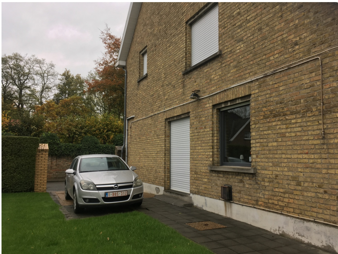
Figuur 37 Zone van de regenwaterput en septische put aan de westelijke zijde van het huis. (bron: erkend archeoloog)
