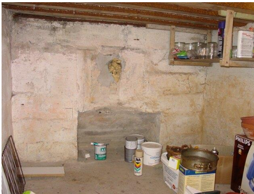
Figuur 60: Ingebouwde mitrailleurspost, Nieuwstraat 4 (Decoodt, Hannelore, 30-05-2005, ©Vlaamse Gemeenschap)
