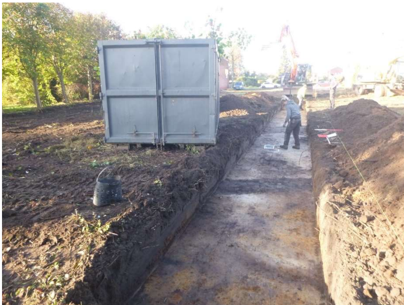
Figuur 12. Container ter hoogte van proefsleuf 2. ©LARES
