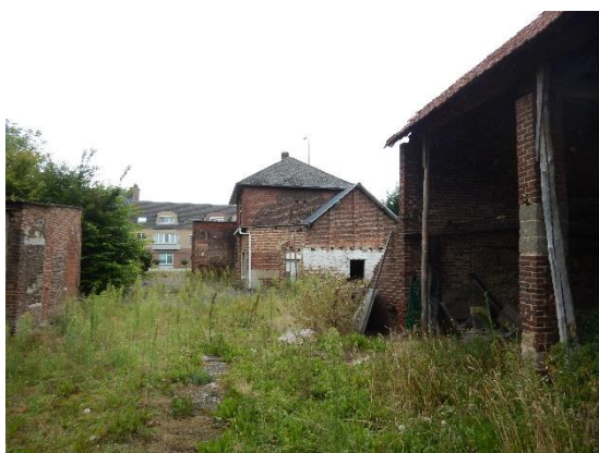
centrale woonhuis (huisnr 423) met achterliggende stallen en de rioleringskoker
