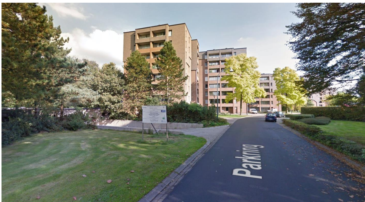
Figuur 2: Zicht op woonheden 5-109 vanop het begin van de Parkring, links vooraan zicht op toegang ondergrondse parkeerplaats 7
