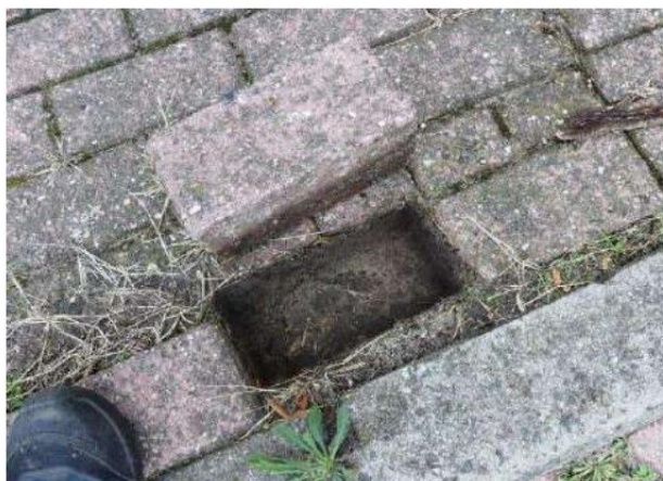
Figuur 4: Straatstenen met onder fundering in gestabiliseerd zand 9
