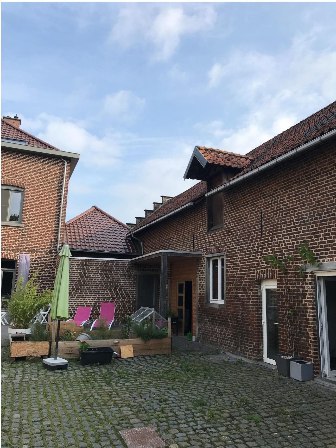
Bestaande stalling ( zijde binnenkoer)
