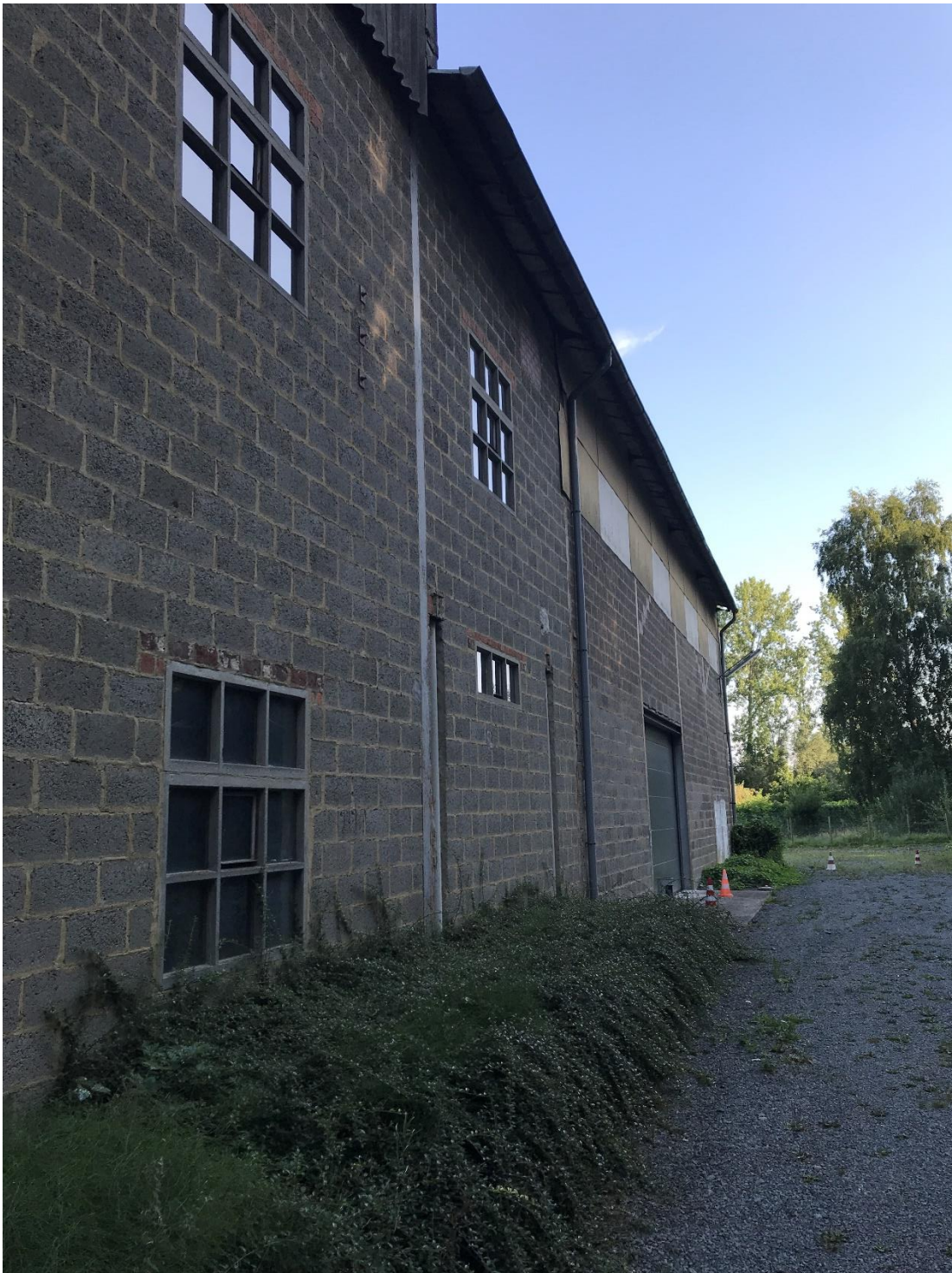
Bestaande loods ( af te breken)
