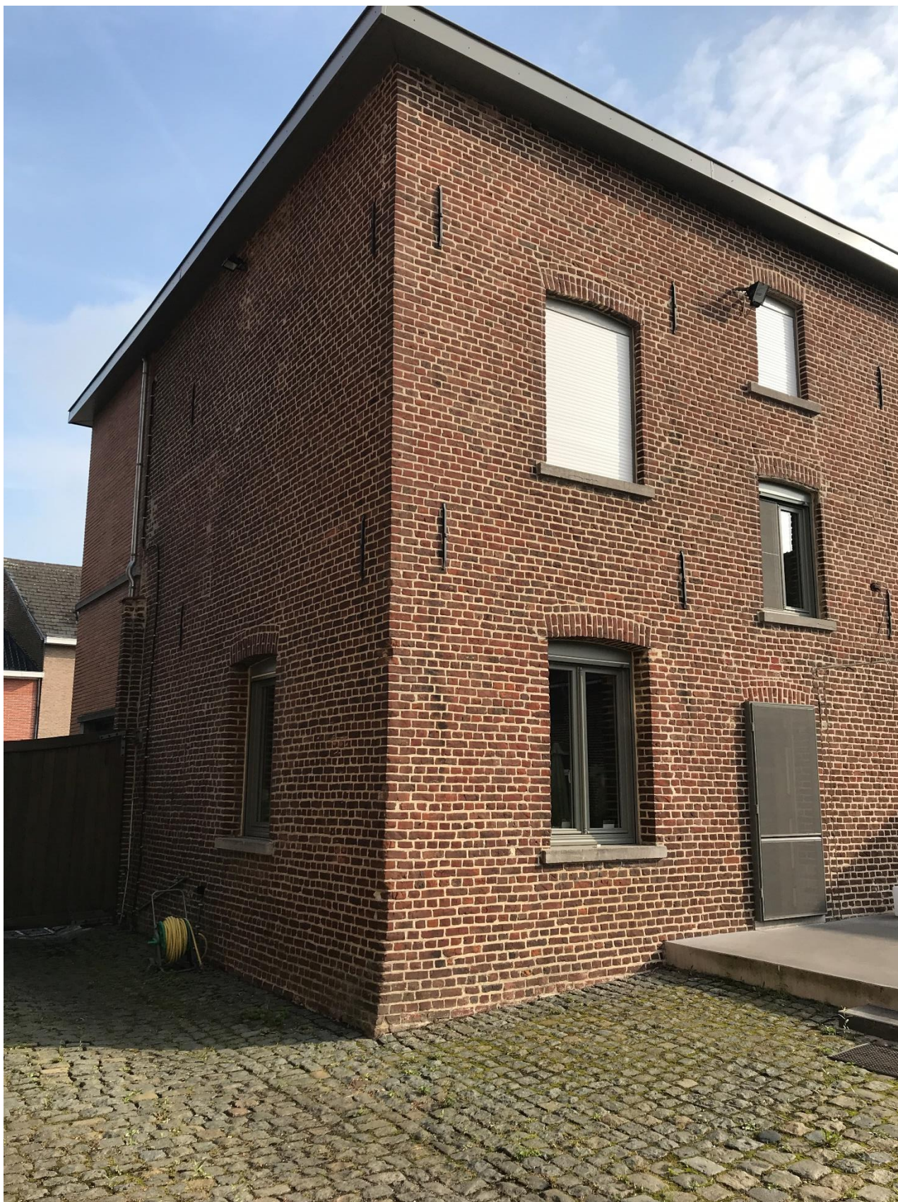
Achterzijde centraal woonhuis (zijde binnenkoer)
