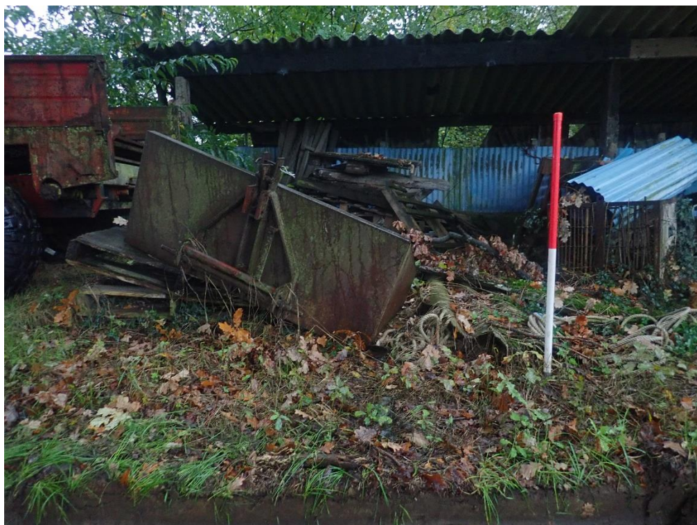
Figuur 28: Zicht op enkele van de aanwezige structuren: detail 6 (© J. Verrijckt Bvba)
