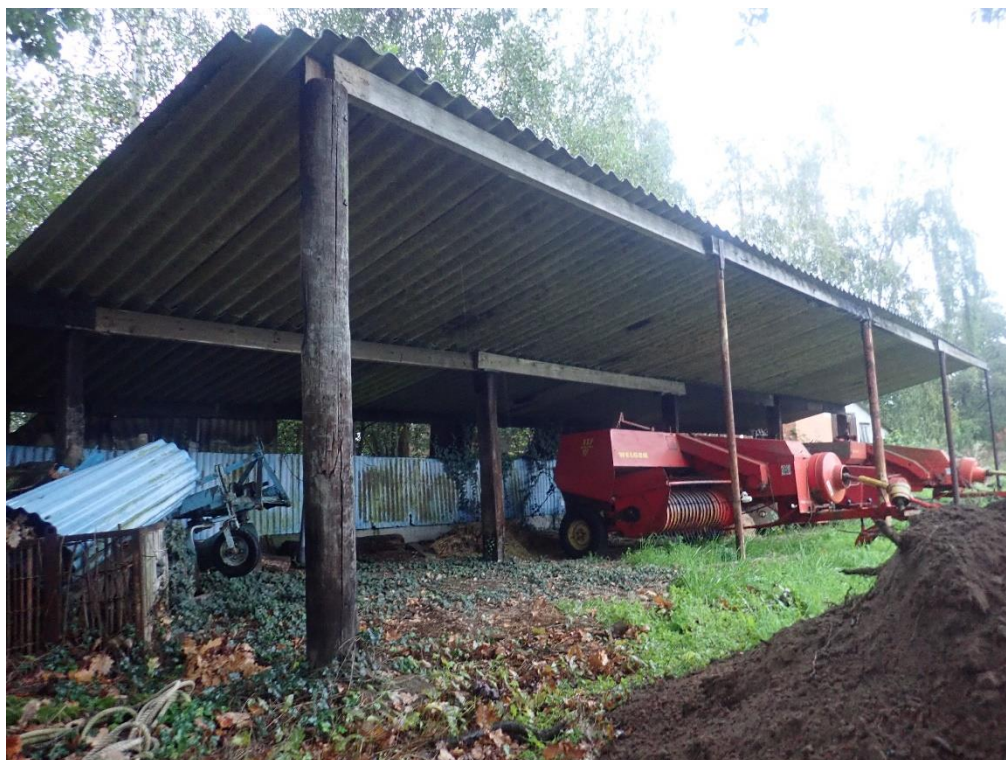
Figuur 29: Zicht op enkele van de aanwezige structuren: detail 7 (© J. Verrijckt Bvba)
