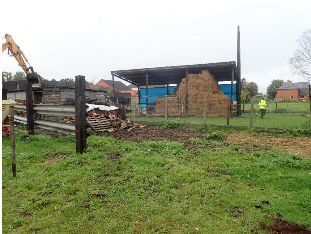
Figuur 31: Zicht op enkele van de aanwezige structuren: detail 9 (© J. Verrijckt Bvba)
