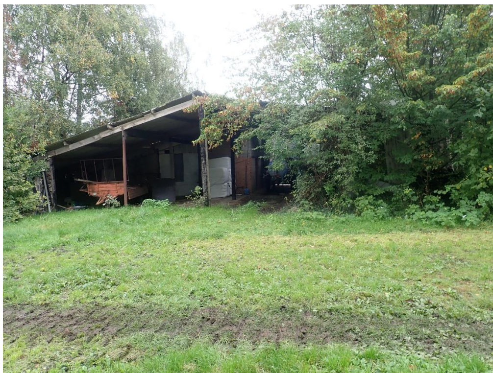
Figuur 26: Zicht op enkele van de aanwezige structuren: detail 4 (© J. Verrijckt Bvba)
