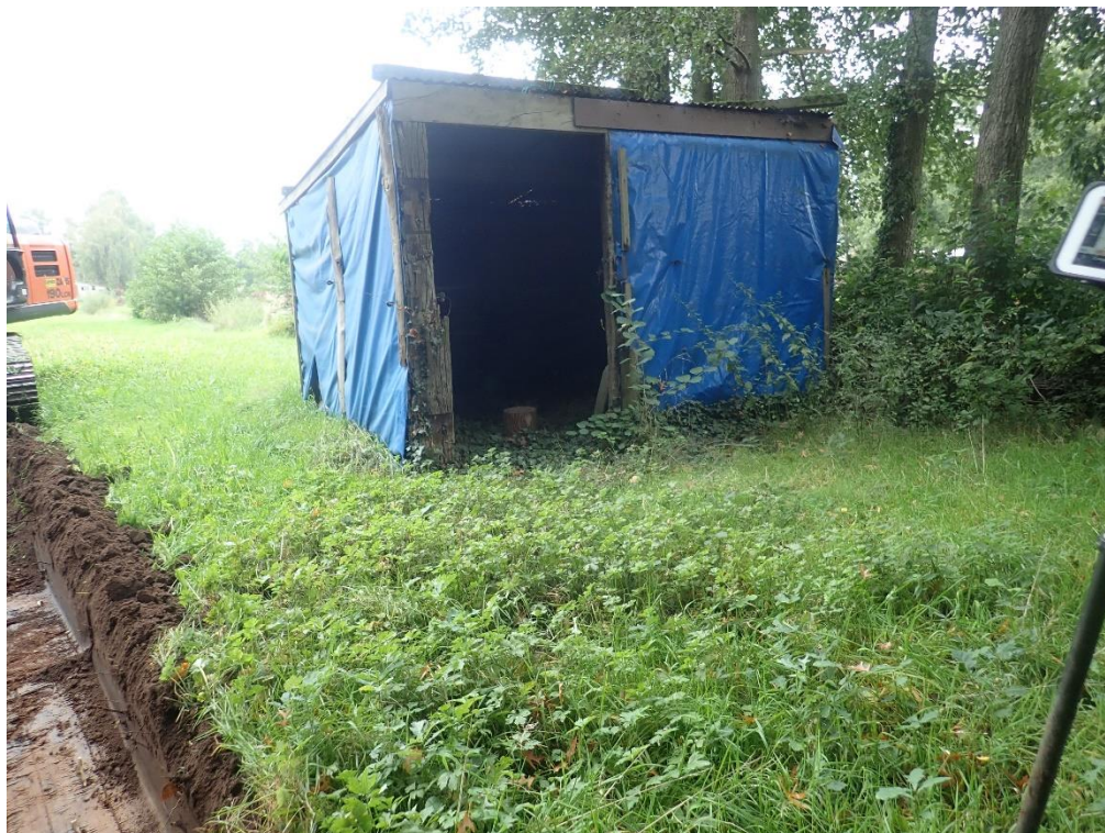
Figuur 27: Zicht op enkele van de aanwezige structuren: detail 5 (© J. Verrijckt Bvba)
