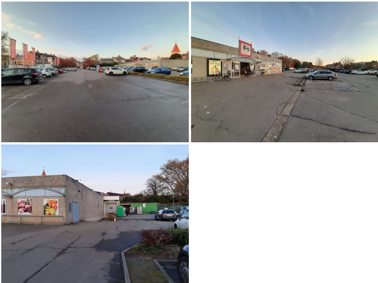
Figuur 29. Zicht op de bestaande winkel met bijhorende parking en loskade. LARES
