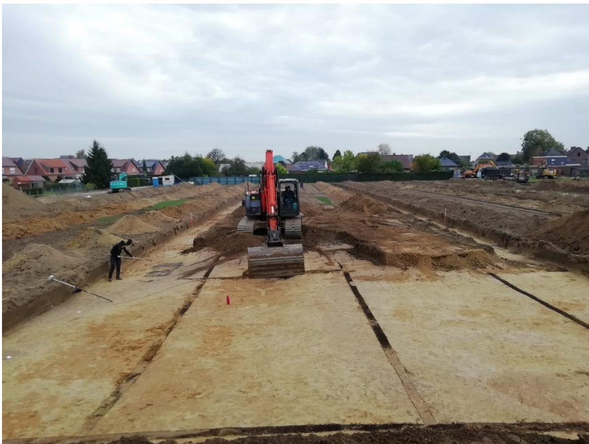
Figuur 61: Aanleg van kijkvenster 1 (foto genomen op 24/10/2019).
