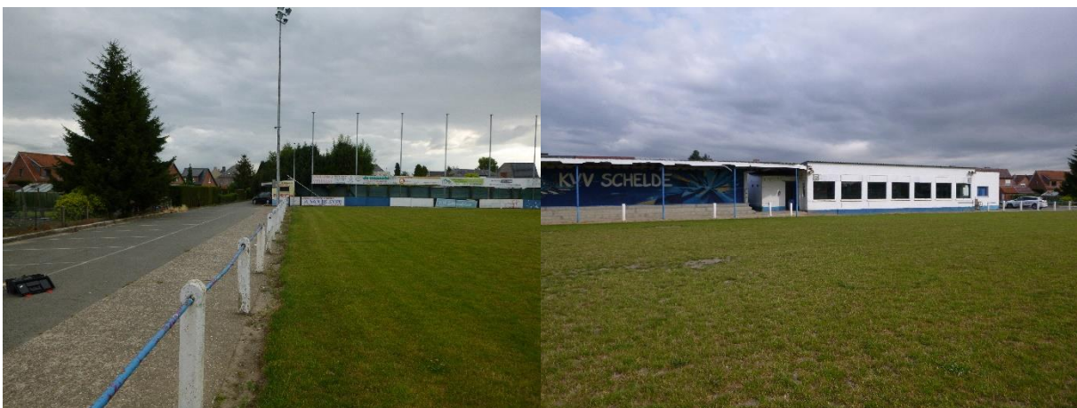
Figuur 36: Omgevingsfoto's ter hoogte van boorpunten BP2 in noordoostelijke richting (links) en boorpunt BP5 in noordwestelijke richting (rechts).
