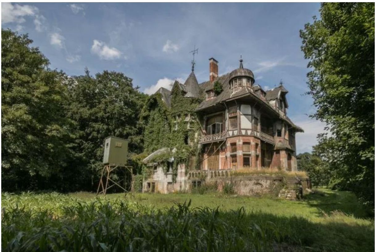
Figuur 19: Kasteel Nottebohm voordat het gesloopt werd (urbanrelics 2019).
