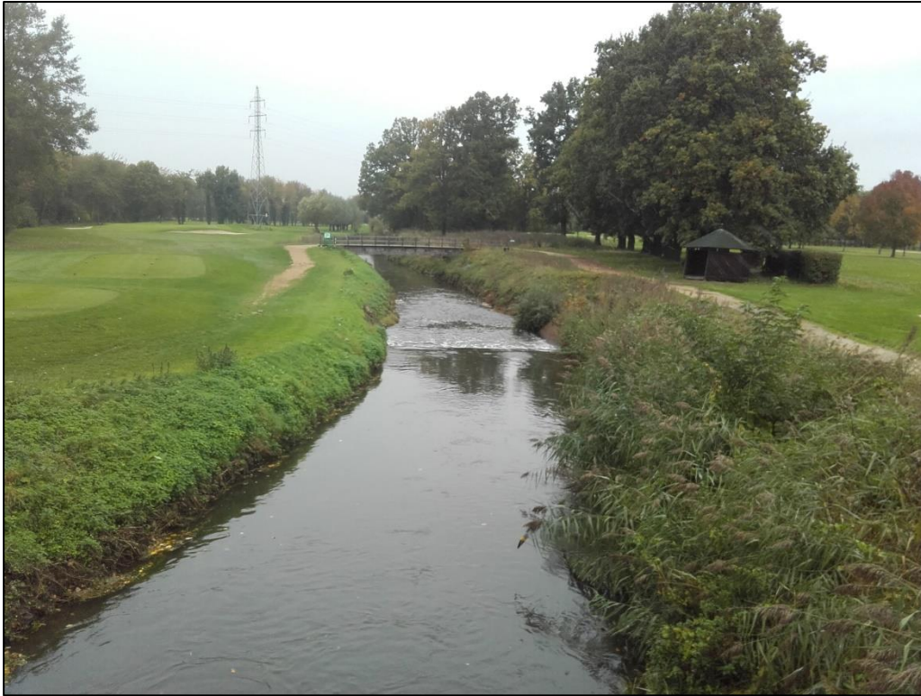
Figuur 10. De Demer, kijkend (vanaf de brug op de Kieselstraat) richting het noorden.
