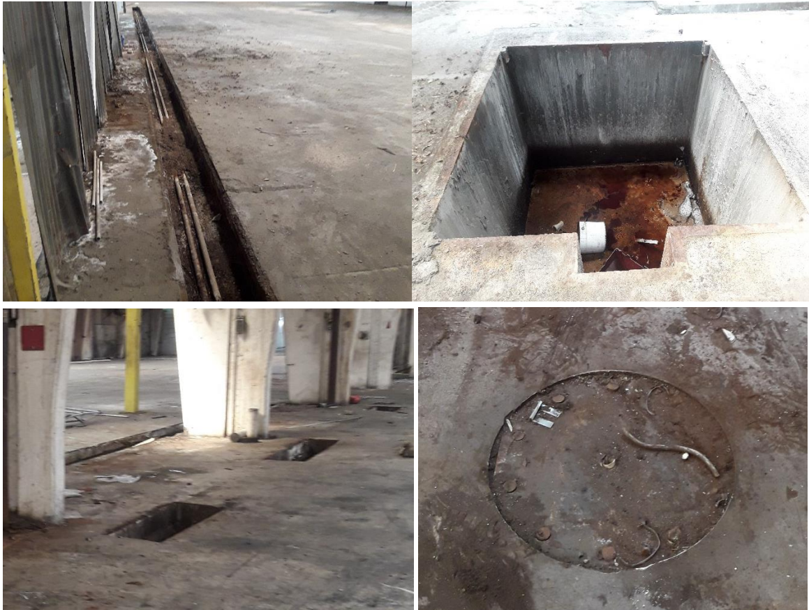
Figuur 14 Zicht op nog andere kleine en/of lokale verstoringen waarvan de diepte niet bekend is. (bron: RAAP België bvba).
