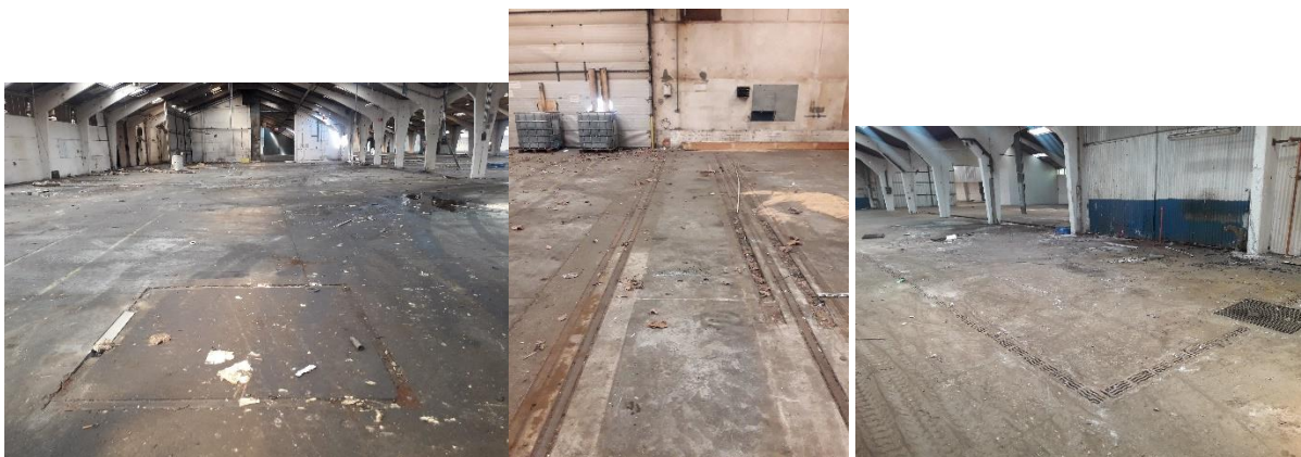
Figuur 13 Zicht op ondiepe verstoringen en lokale putten, waarvan de dieptes niet bekend zijn (bron: RAAP België bvba).
