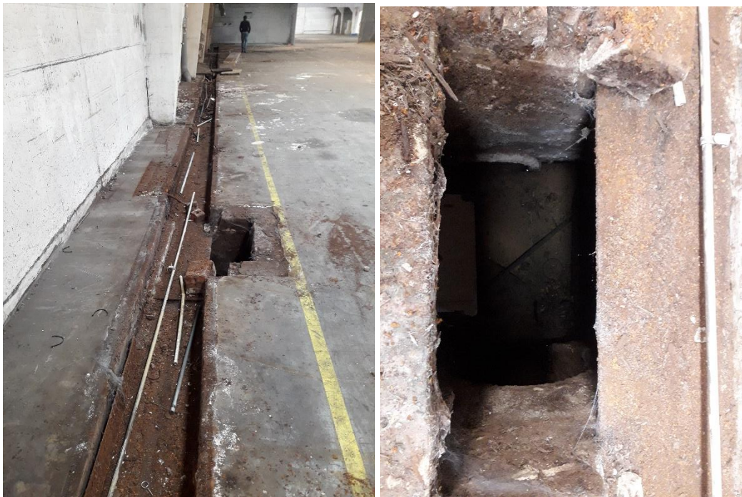
Figuur 12 Linkerfoto: Zicht op één van de goten. Rechterfoto: Detail op één van de goten met afvoerbuis (bron: RAAP België bvba).
