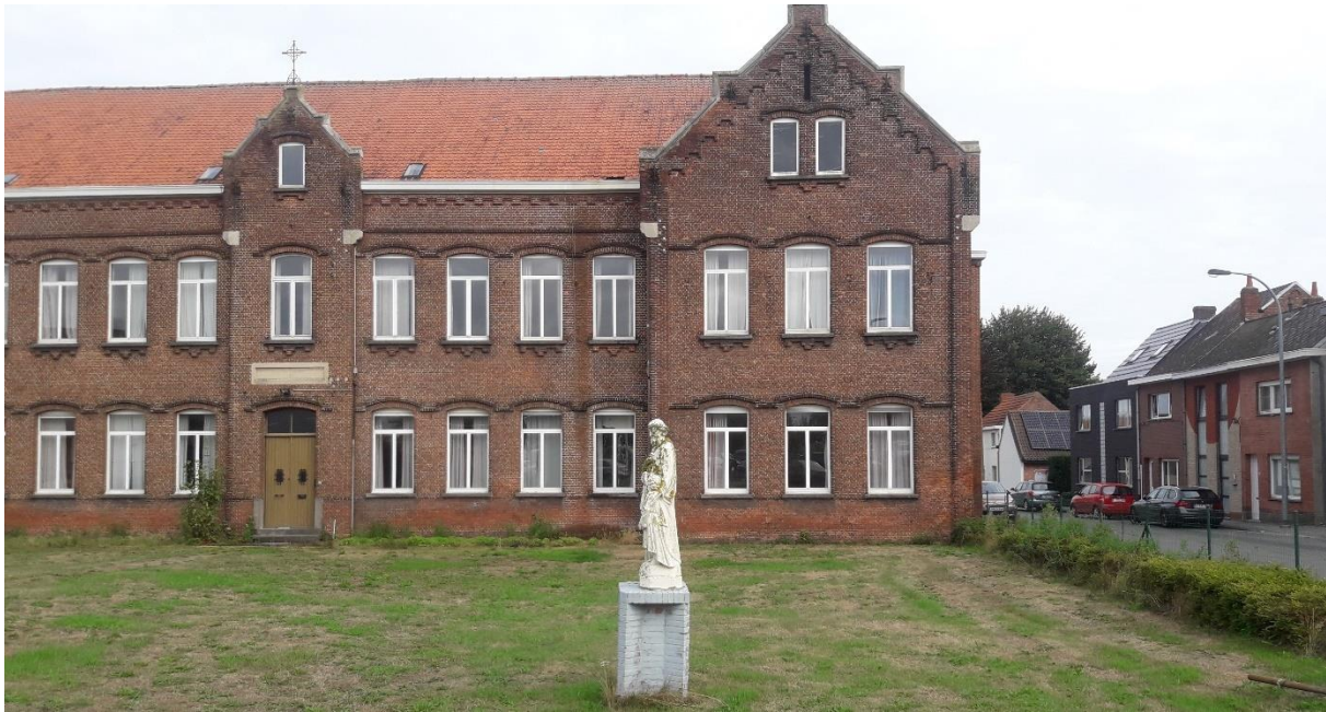
Foto 5 : Zicht op het plangebied ter hoogte van boring 2 met op de achtergrond het kloostergebouw, gezien vanuit het zuiden
