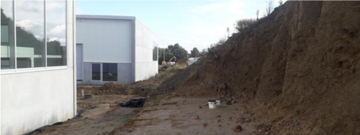
Figuur 12 : Zicht op het noordwestelijk deel van het plangebied ter hoogte van boring 8, gezien vanuit het westen. (©BAAC)
