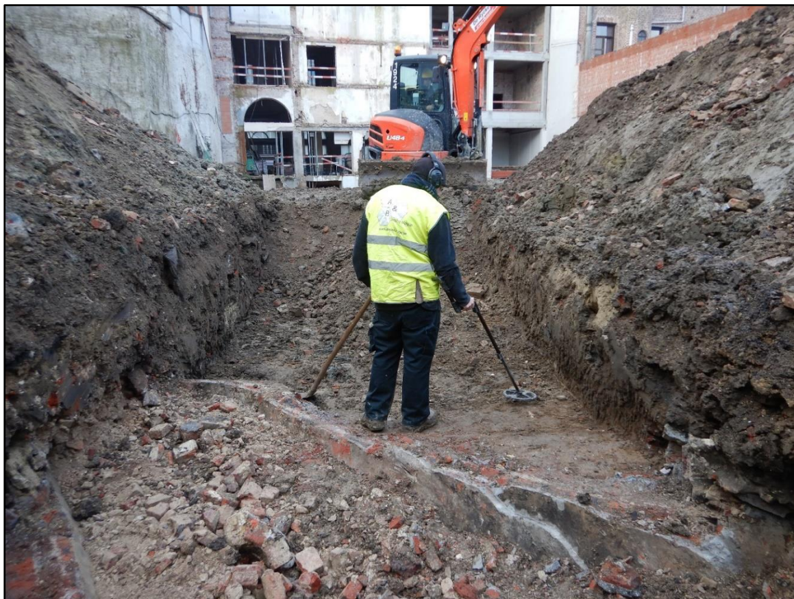
Figuur 11 Metaaldetectie tijdens de aanleg van de sleuven.
