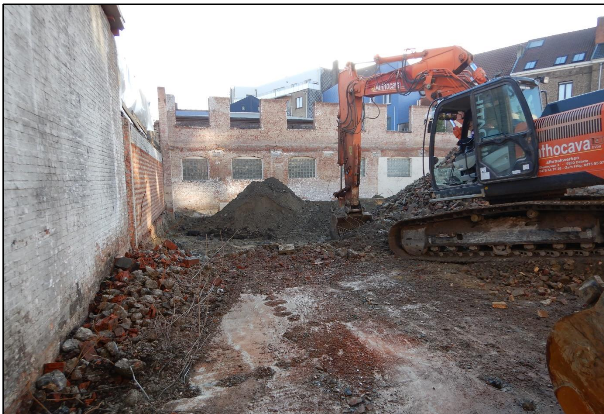
Figuur 6 Sfeerbeeld tijdens het uitbreken van de betonplaat.
