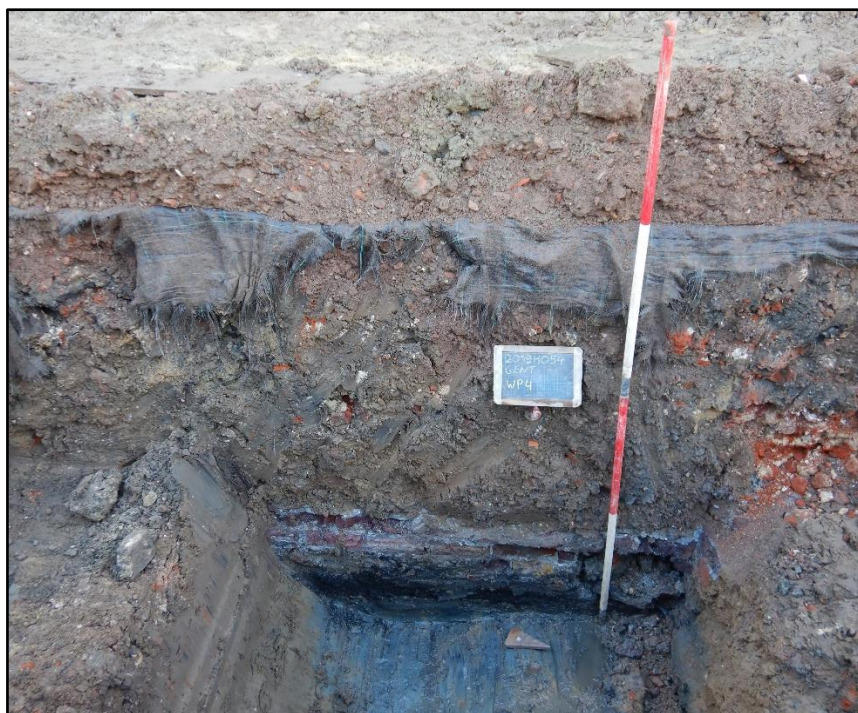
Figuur 20 Rand van een aftakking (baksteen met grijze cement) van de overwelfde beek in het zuidelijke deel van het plangebied (sleuf 4).
