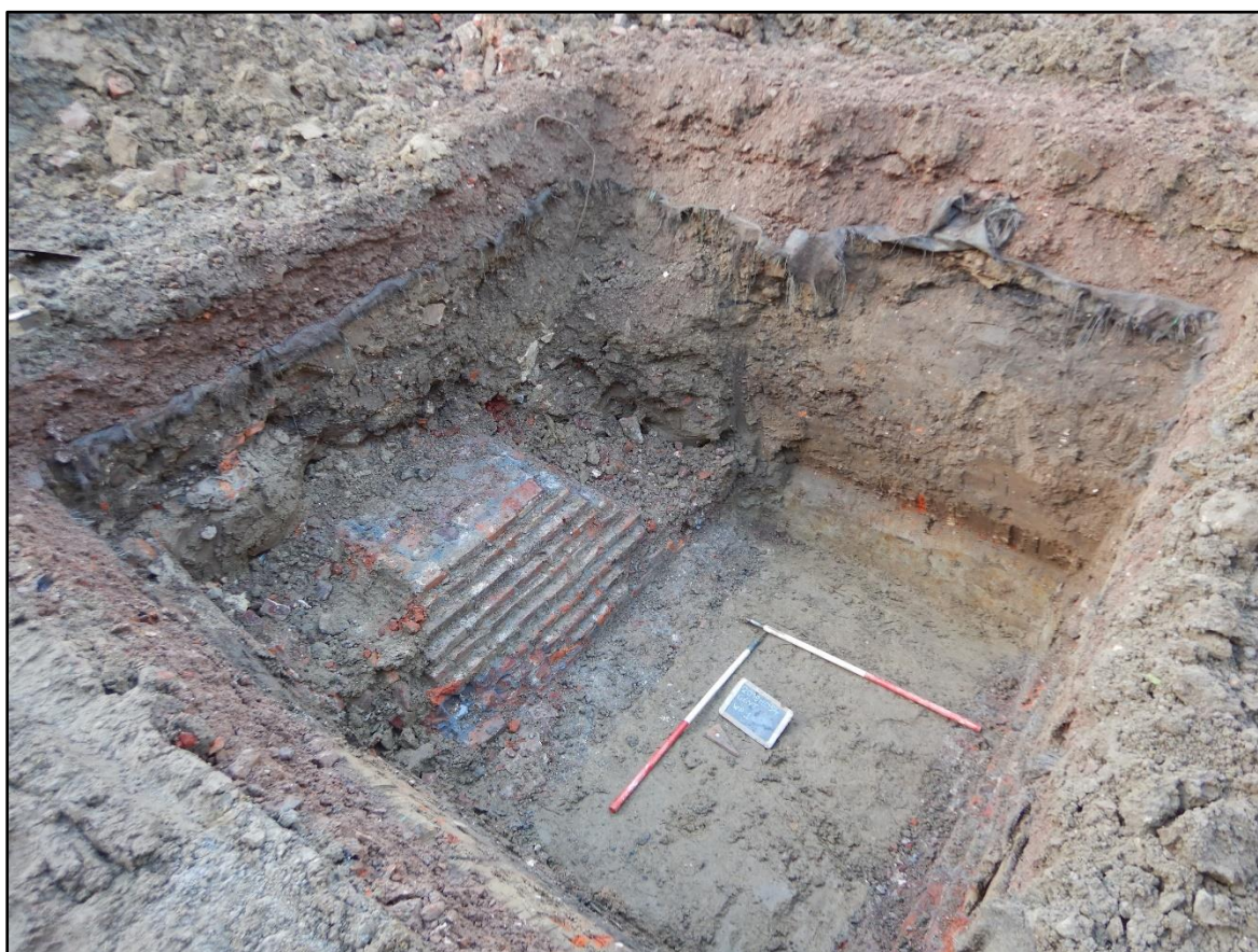
Figuur 21 19 de /20 ste -eeuwse funderingssokkels (links en rechts aan de profielwand) in baksteen en grijze cement (sleuf 1 – S4, 5, 6 en 7).
