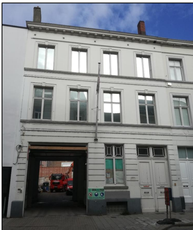
Figuur 2 Zicht op de voorgevel en toegang aan de Tweebruggenstraat.
