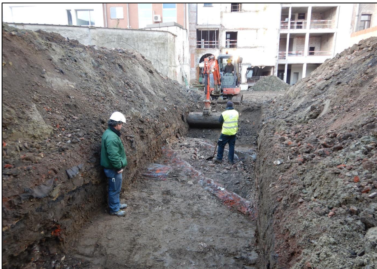
Figuur 10 Sfeerbeeld tijdens de aanleg van sleuf 3.
