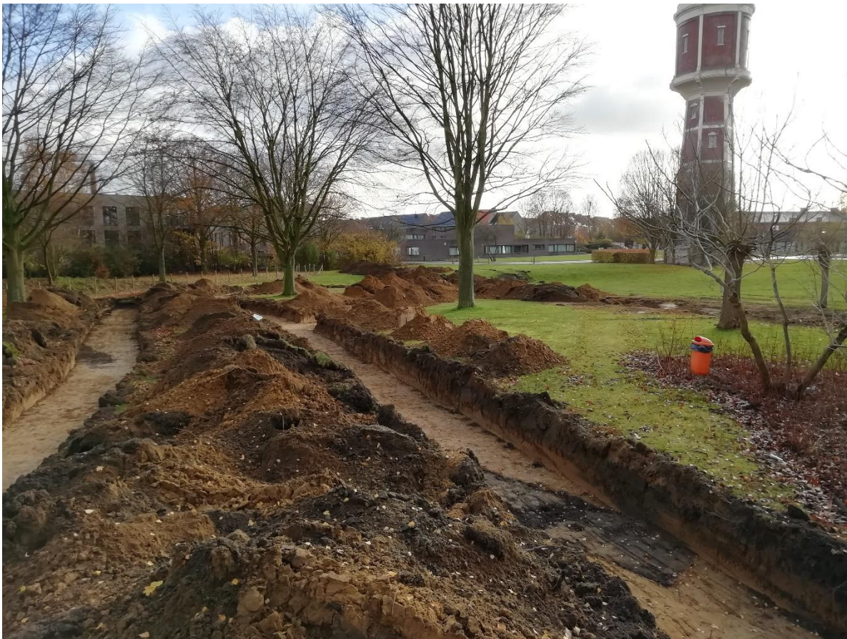
Figuur 10: Zuiden van het projectgebied na aanleg sleuven op 2/12/2019.
