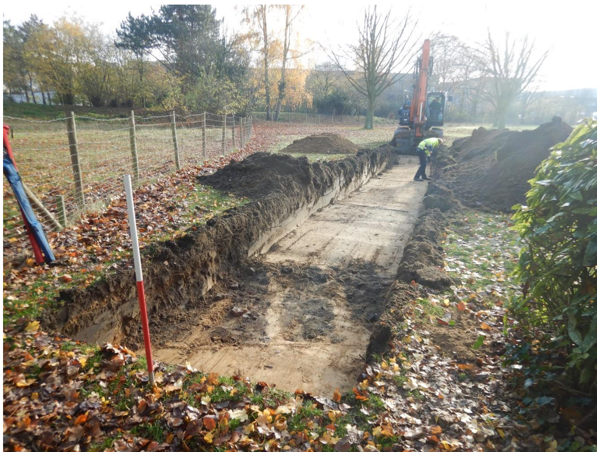
Figuur 9: Aanleg van proefsleuf 1 (2/12/2019).
