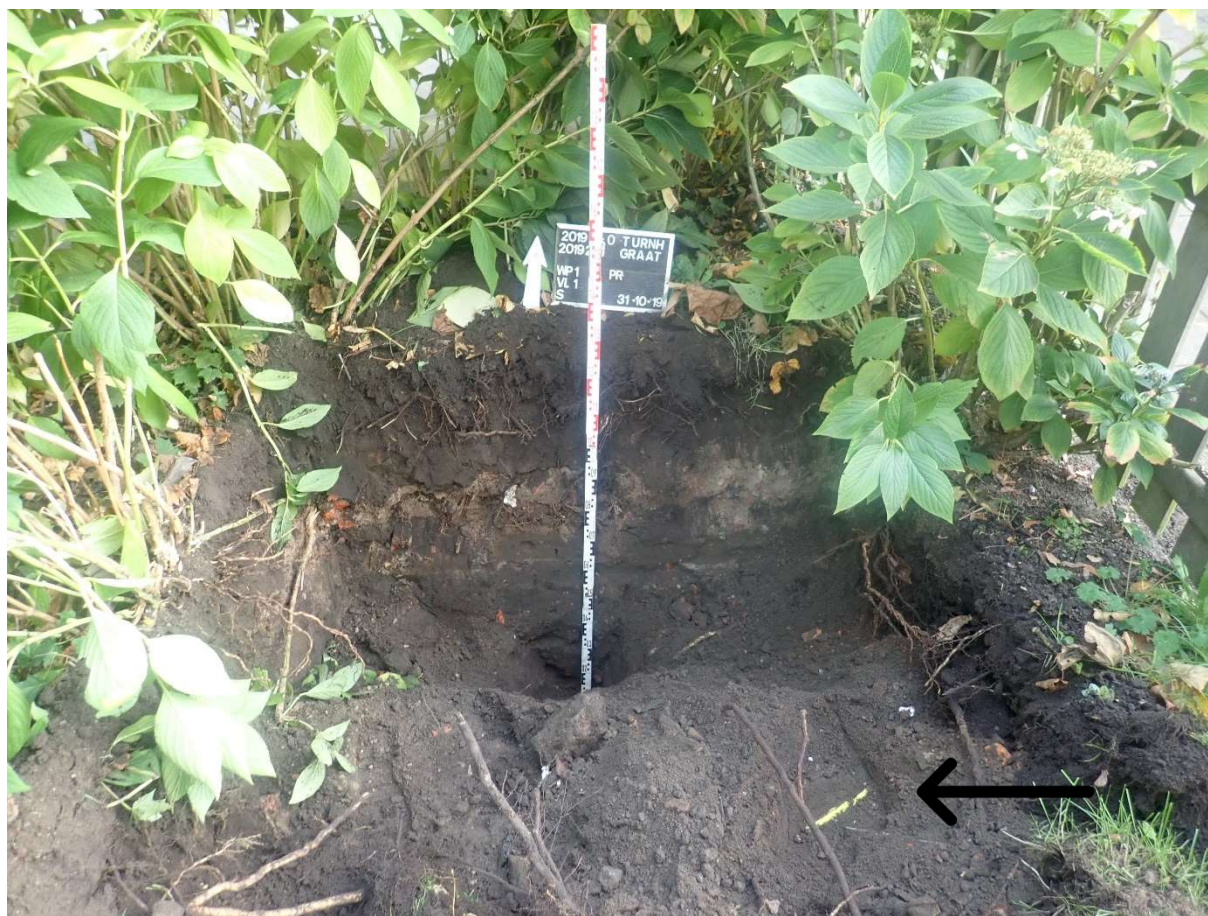
Figuur 17: Zicht op WP1 met aanwezige leiding (© J. Verrijckt Bvba)
