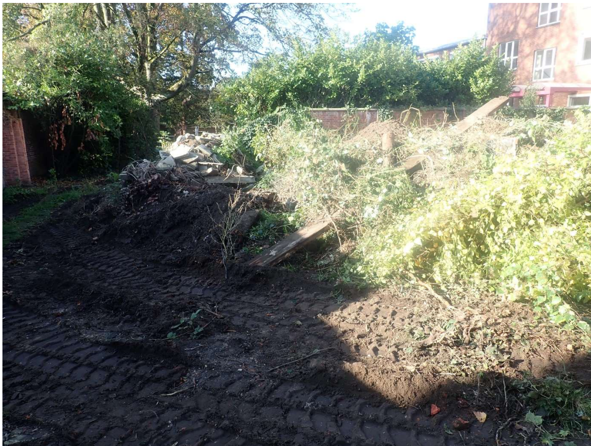
Figuur 9: Zicht op de aanwezige steenpuin
