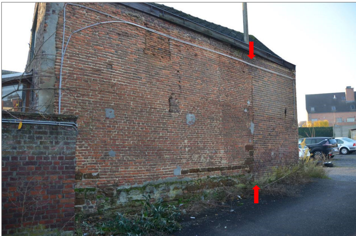
Figuur 9. Noordwest-gevel van de achterbouw van pand Schotlandstraat 29 met bouwnaad (rode pijltjes), gezien vanop de toegangsweg van pand nr 27. (Foto: Triharch 03/12/2019)
