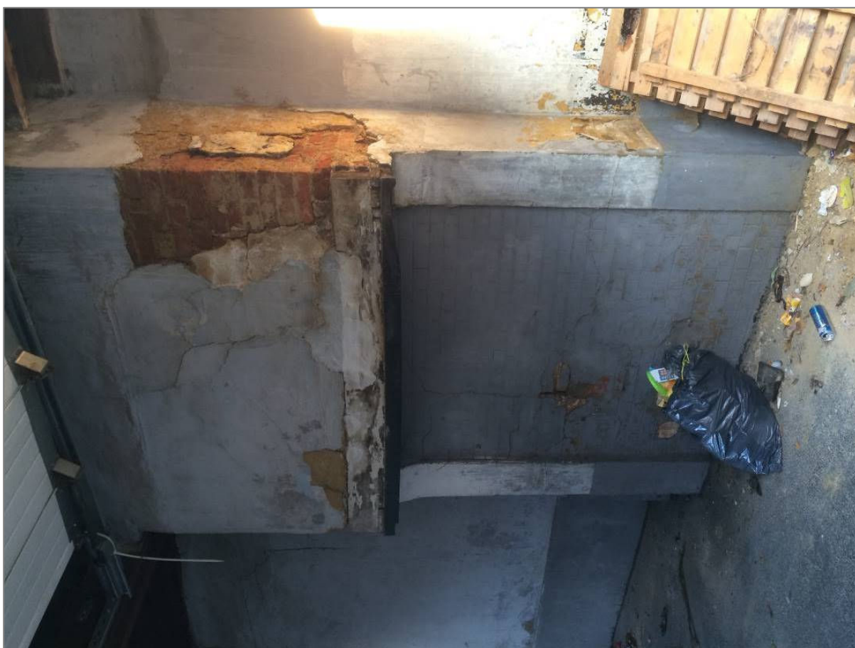
Figuur 13. Schouw in het toegangsvertrek van pand Schotlandstraat 27. (Foto: Triharch 03/12/2019)
