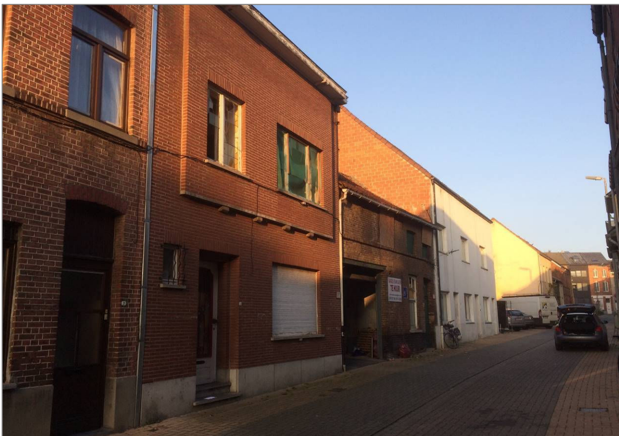
Figuur 5. Voorgevel van de panden Schotlandstraat 29 (links) en 27 (rechts). (Foto: Triharch 03/12/2019)
