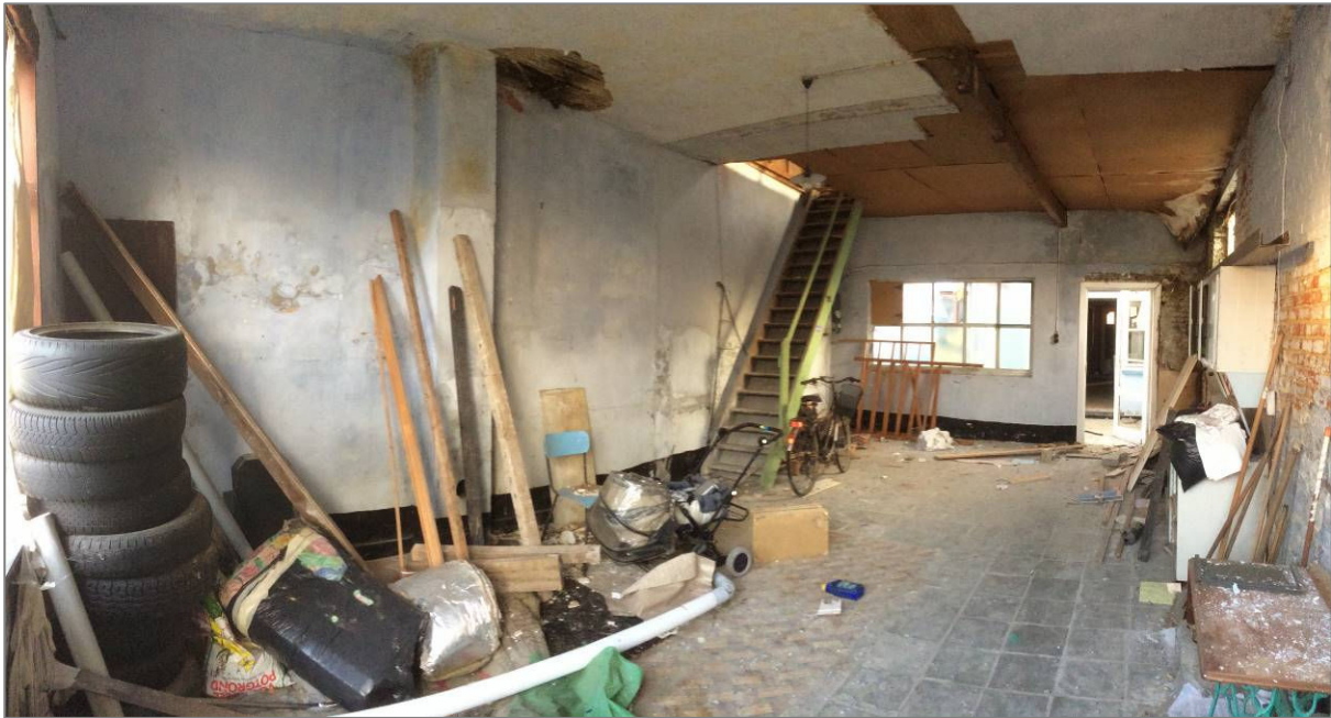
Figuur 8. Interieur van de achterbouw van pand Schotlandstraat 29. (Foto: Triharch 03/12/2019)
