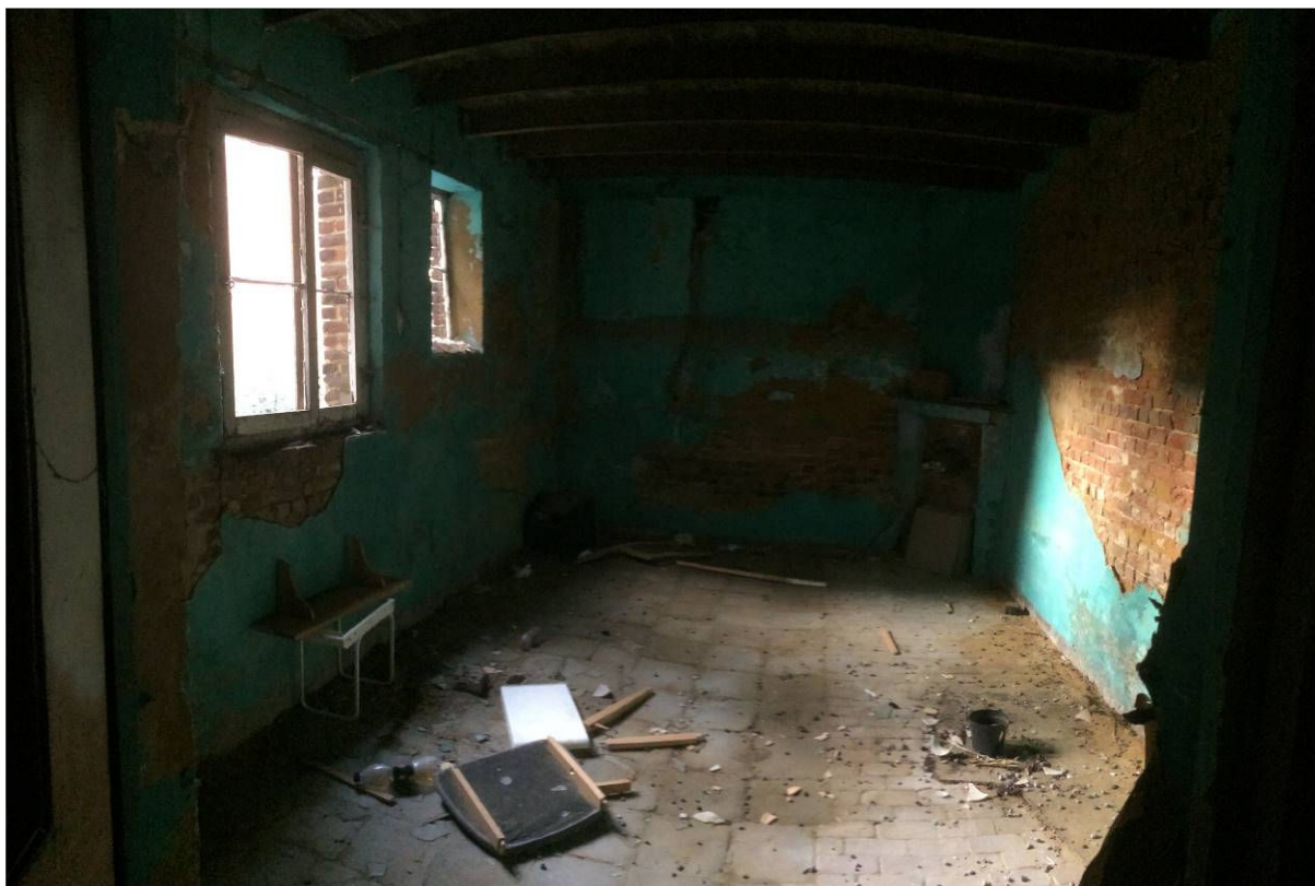
Figuur 12. Aanbouw van pand Schotlandstraat 27. (Foto: Triharch 03/12/2019)
