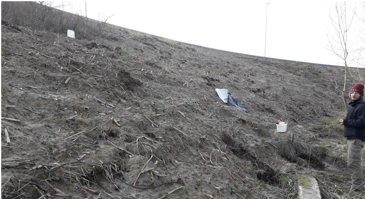
Figuur 34 : boring 5, niet uitgevoerd, locatie te hoog op de talud gelegen
