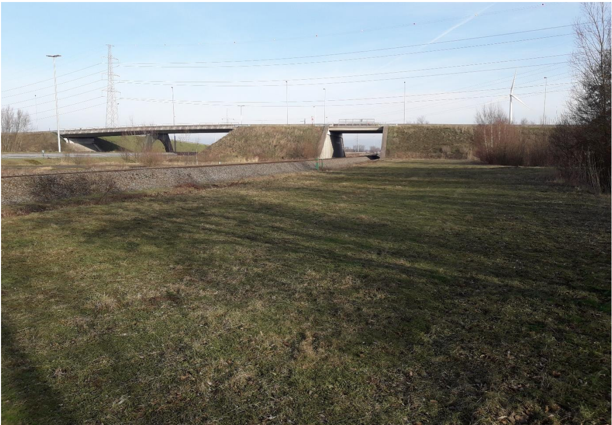
Figuur 26 : Noordwestelijk zicht op het plangebied W4b genomen nabij boring 3
