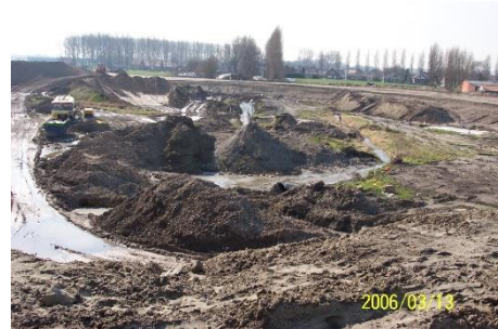
Figuur 4: Foto aanleg ovonde 14
