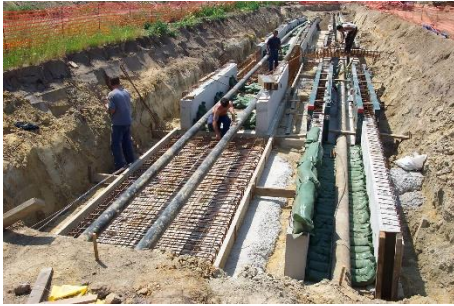
Figuur 1: Foto aanleg ovonde 11
