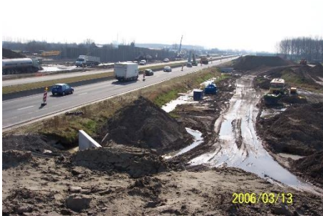
Figuur 3: Foto aanleg ovonde 13
