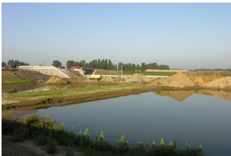
Figuur 5: Foto aanleg ovonde 15
