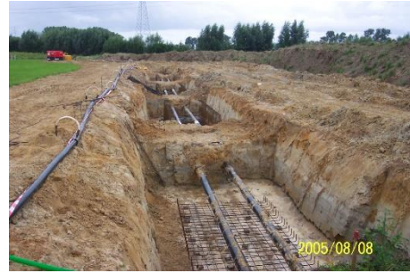
Figuur 2: Foto aanleg ovonde 12
